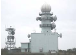
レーダ雨量計（赤城山レーダ）
