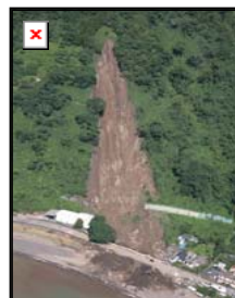
二川地区の土石流(鹿児島県垂水市)
