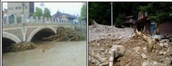
浅野川大橋の流木堆積状況(金沢市) 土砂災害により人家2戸半壊(南砺市)
