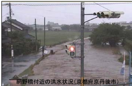
網野橋付近の洪水状況(京都府京丹後市)
