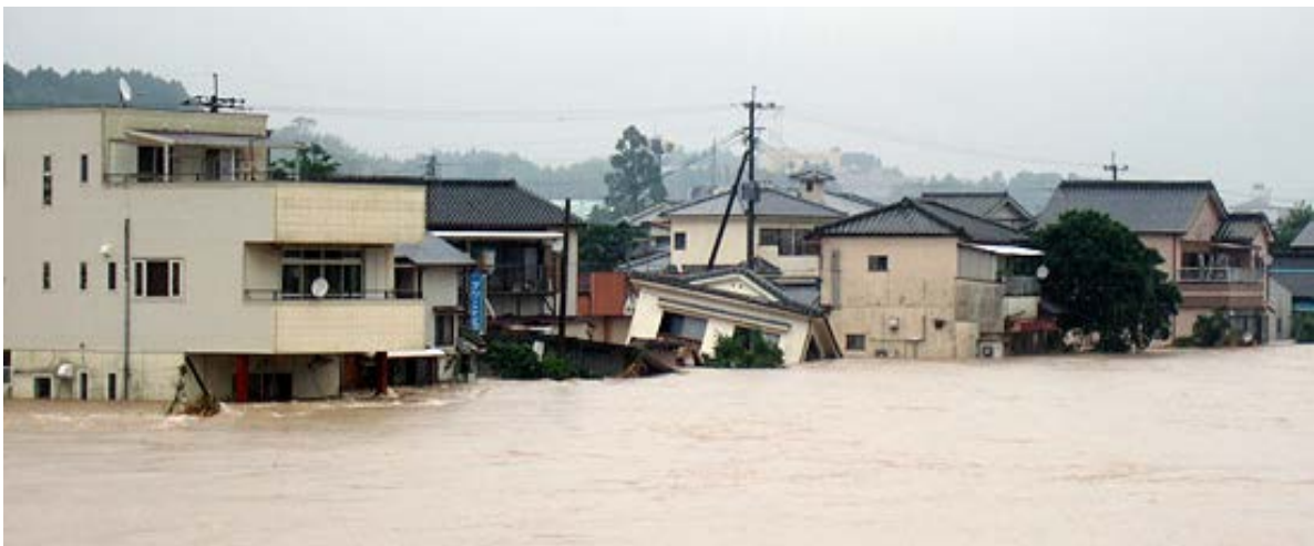
さつま町虎居地区の被災状況（平成18年）
