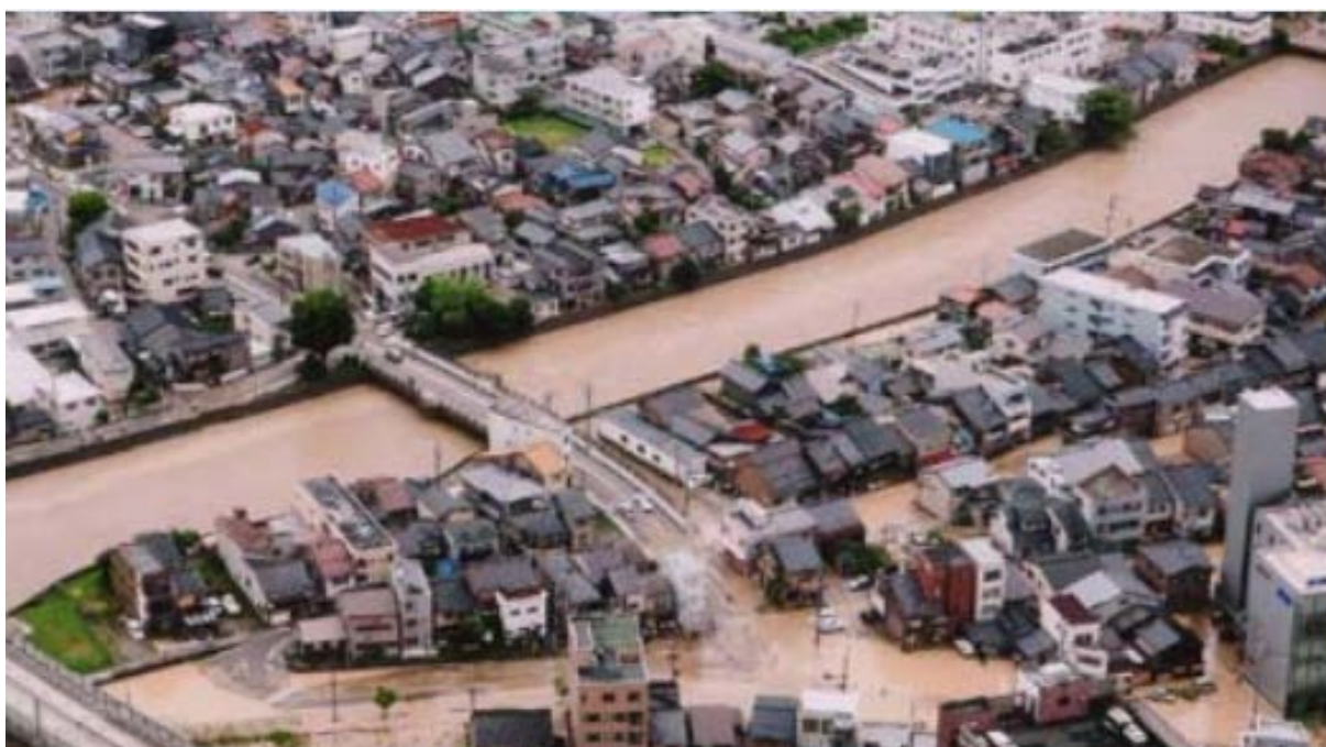
金沢市市街地の浸水状況（平成 20 年 7 月）
