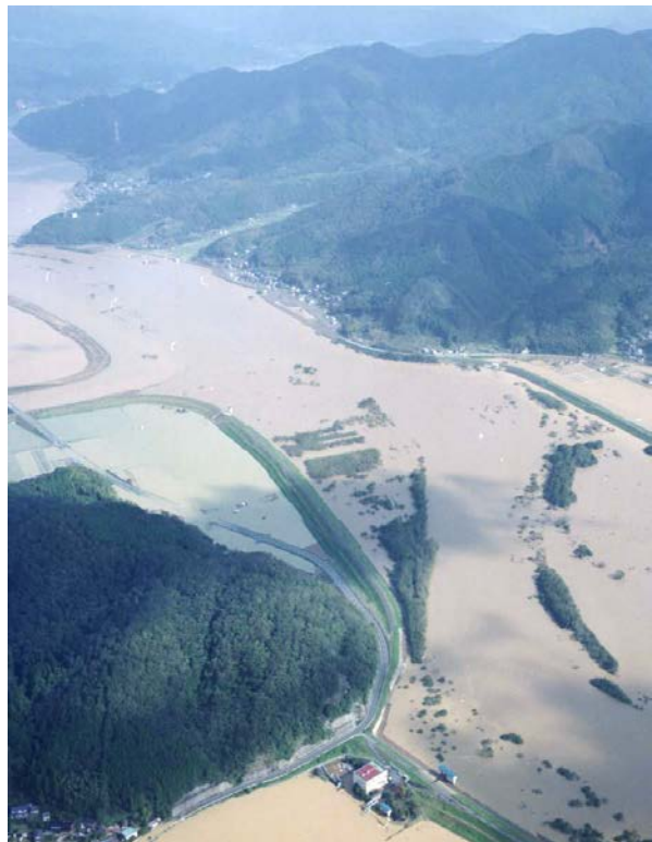
氾濫により浸水した福知山市の様子 (出典：『2004年10月台風23号』近畿地方整備局福知山河川国道事務所 HP)
