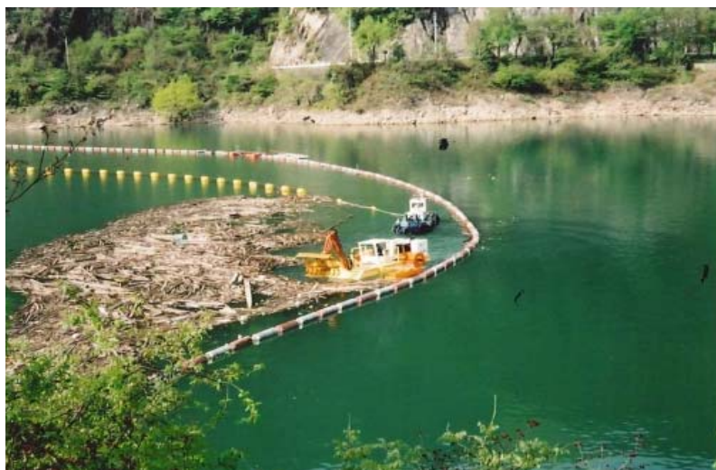
[パワーレーキ式の作業船による補助的な作業]
