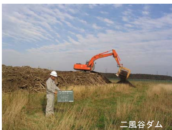
写真 6.2 スケルトンバケットを搭載したバックホウによる分別作業
