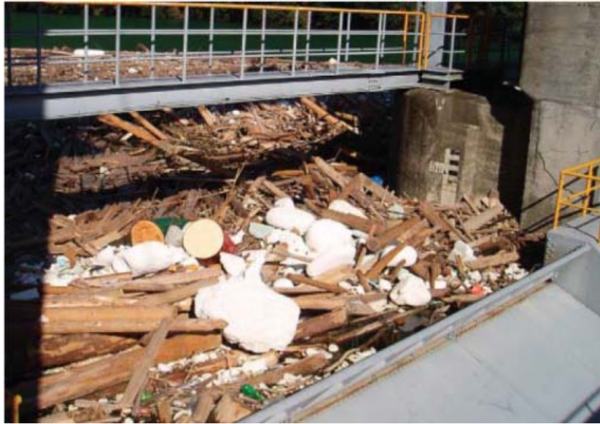
写真 6.3 大内原ダム（九州電力（株））の洪水吐き前面に貯留した流木 1)
