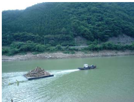
写真 1.2 台船上のクレーンによる流木回収状況
