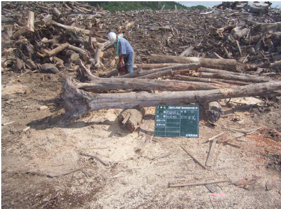
写真 1.7 流木玉切り状況
