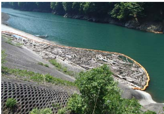
左：集めた流木が拡散しないよう簡易網場で処置 右：水位低下時の状況
