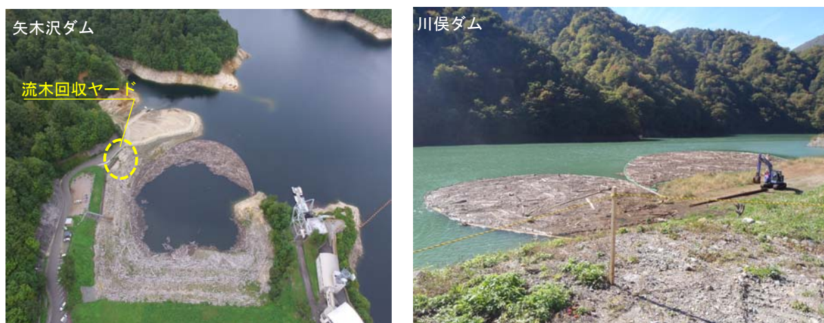
写真 4.4 流木の再拡散防止対策
