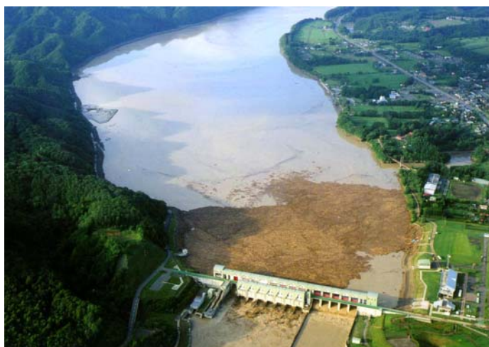
写真 3.1 平成 15 年二風谷ダムにおける網場の切断後の状況
