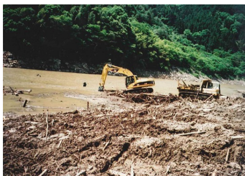
写真 1.3 バックホウによる流木回収状況
