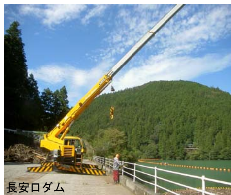
写真 4.2 クレーンによる陸揚げ事例
