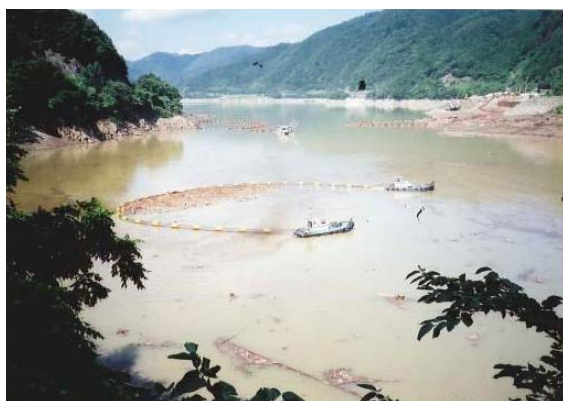
[作業船と集積用簡易網場による回収]
