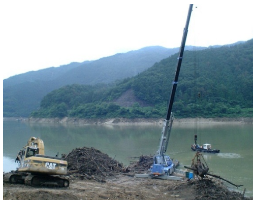
〔クレーンによる陸揚げ〕
