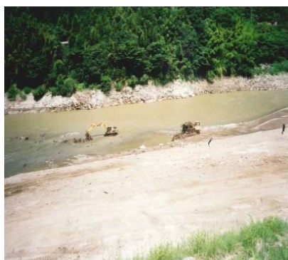
写真 1.3 バックホウによる流木回収状況
