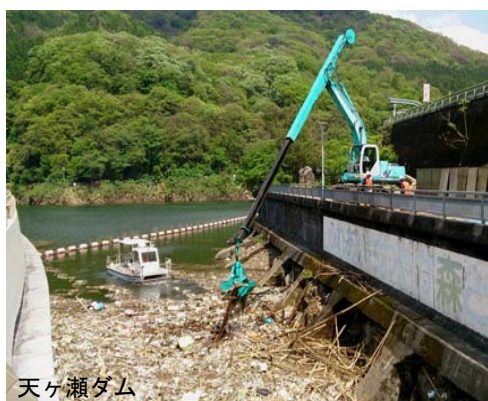
写真 4.2 クレーンによる陸揚げ事例
