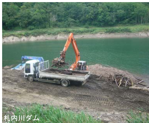
写真 4.1 バックホウによる陸揚げ事例
