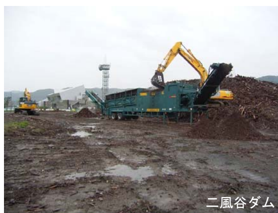
写真 6.2 スケルトンバケットを搭載したバックホウによる分別作業
