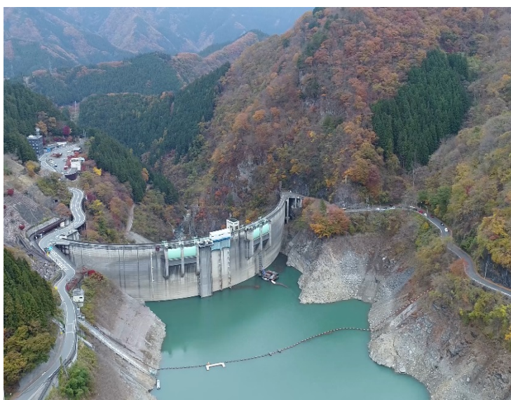
写真 3.7 二瀬ダムにおける網場の設置状況
