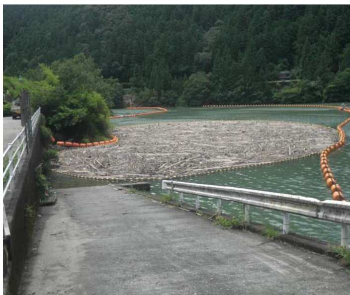
写真 3.2 捕捉した流木の回収状況
