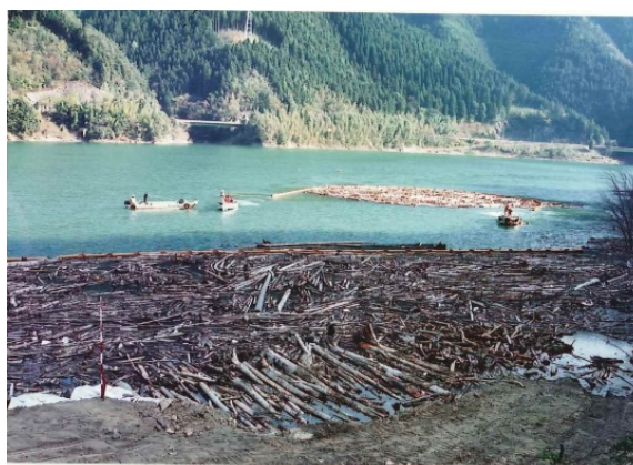
[作業船と集積用簡易網場による回収]
