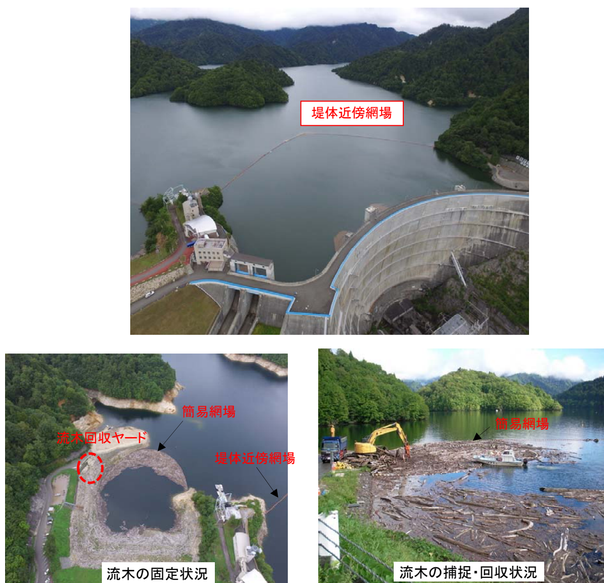
写真 3.6 矢木沢ダムにおける堤体近傍網場と流木回収ヤードの簡易網場
