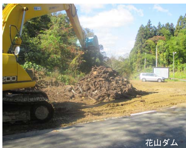
写真 6.2 スケルトンバケットを搭載したバックホウによる分別作業
