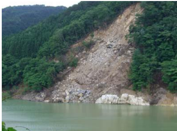
写真-6.1 貯水池法面崩落状況
