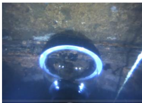
写真 4.4.4 漏水検知装置使用状況
