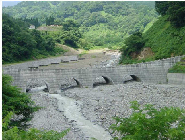
図 3-8 天然ダムが決壊時に流出する土砂・泥水の流出制御のための施設の整備事例 (スーパー暗渠砂防堰堤)
