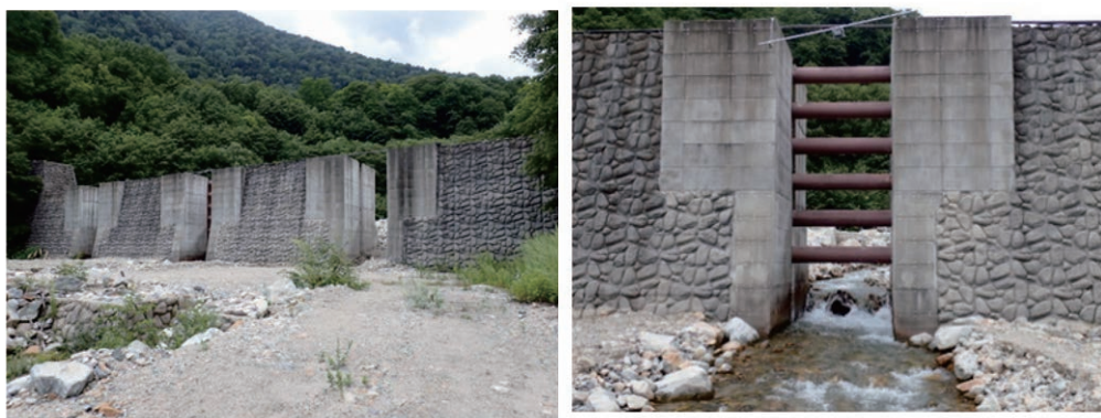
図3-4 中期（土砂流出活発期）における土砂の流出抑制あるいは調節のための施設の整備事例（シャッター砂防堰堤）
