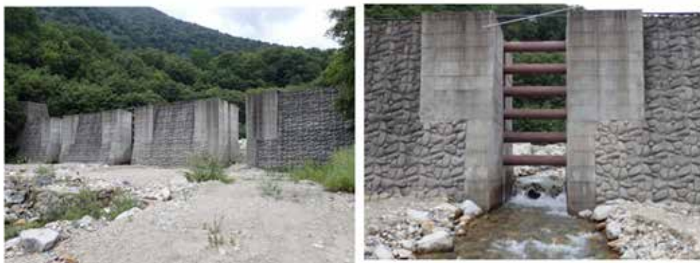
図3-4 中期（土砂流出活発期）における土砂の流出抑制あるいは調節のための施設の整備事例（シャッター砂防堰堤）
