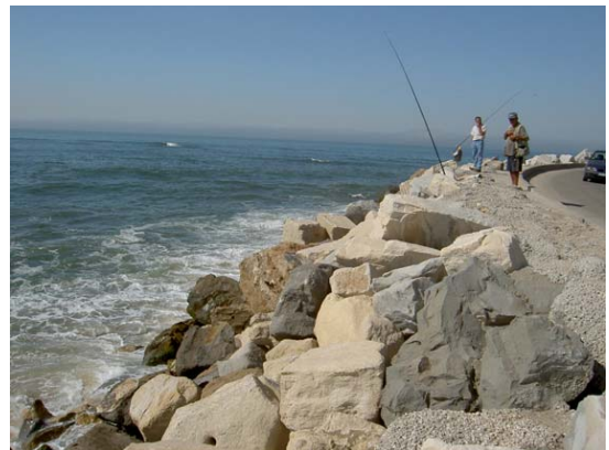
写真-73 大ぶりの自然石を用いて積み上げられたことにより人工的印象がやわらいだ護岸
