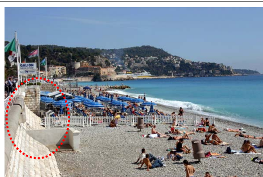
写真-58 サービス施設（トイレ）等が一体的に収められた護岸
