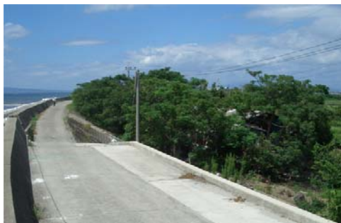
写真-52 背後を緑化し人工的印象を軽減した干拓堤防
