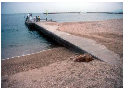
写真-89 突堤を挟む両側の汀線の不整合
