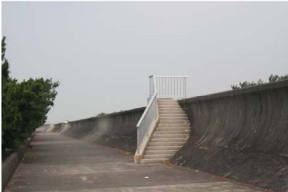
写真-120 海岸堤防に対する収まりの良くない管理用階段
