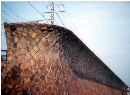
写真-83 波返し工の形状や素材の持つ特性を活かした護岸の造形
