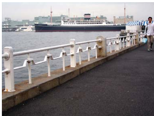
写真-133 過度に自己主張せず、透過性の確保された転落防止柵
