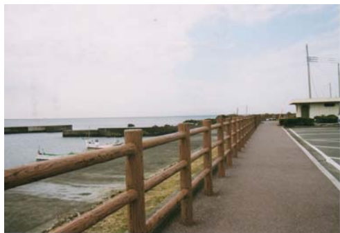
写真-132 存在感が大きく不自然な擬木を用いた転落防止柵
