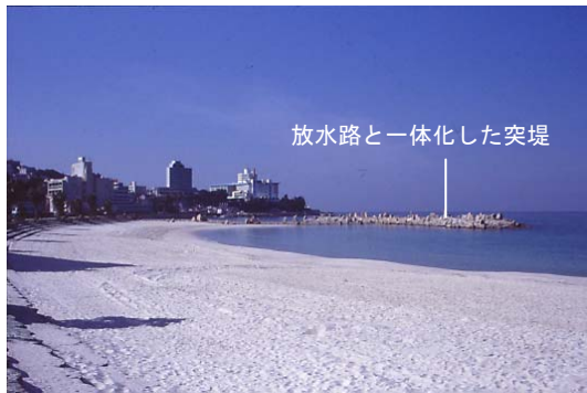
写真-70 放水路を突堤内部に収めて一体化した突堤
