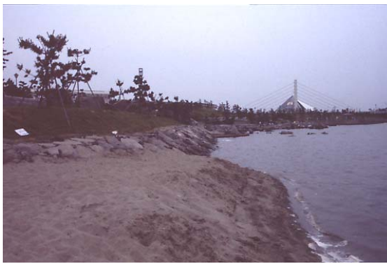
写真-96 突堤断面が緩傾斜で水面に接して、砂浜と滑らかにすり付く突堤
