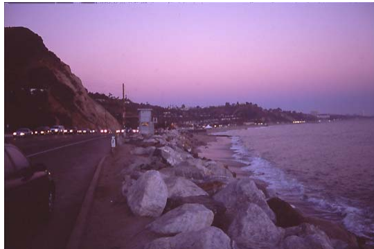
写真-73 大ぶりの自然石を用いて積み上げられたことにより人工的印象がやわらいだ護岸
