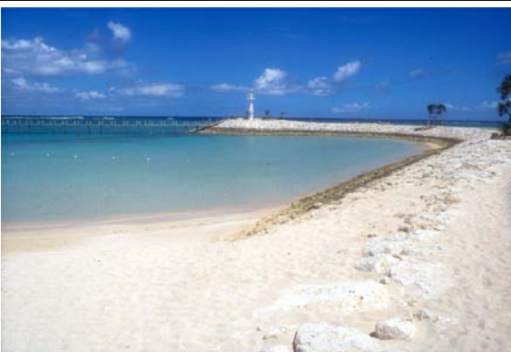
写真-94 砂浜との一体感のある構造物（突堤）のデザイン
