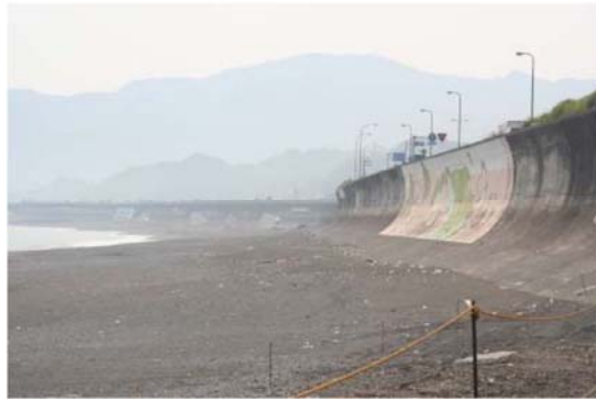
写真-82 ペインティングにより景観上課題のある海岸堤防法面
