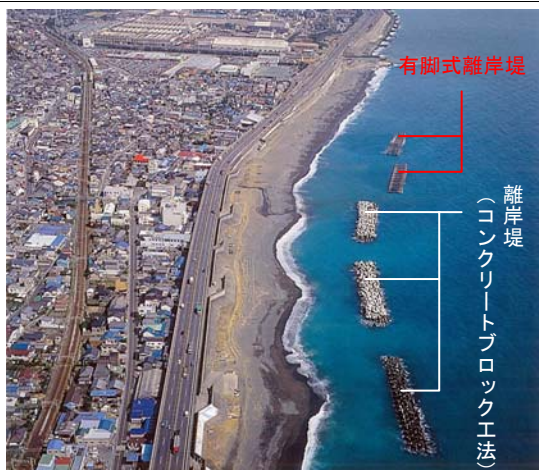
写真-85 自然な汀線形状を形成する有脚式の新型離岸堤
