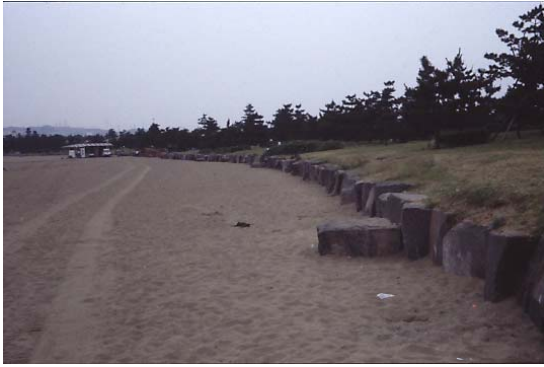
写真-79 自然石を用いて処理した緑地帯と砂浜との境界部の海岸護岸
