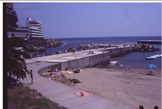
写真-56 突堤によって分断された印象が強い海岸
