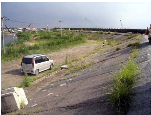
写真-51 背後の法面を緩傾斜化して人工的印象を軽減した干拓堤防
