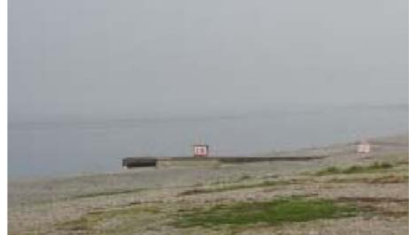
写真-69 汀線を分断する放水路
