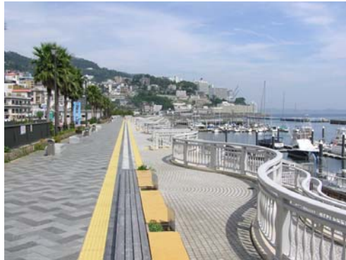
写真-131 自己主張が強く、海岸景観の主役を奪っている転落防止柵
