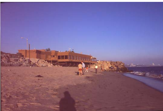
写真-130 護岸と同程度の高さに抑えられた建築物
