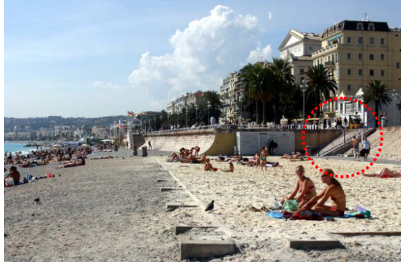
写真-123 護岸の勾配にすり合わせて収められた階段
