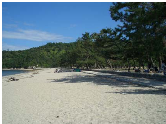
写真-71 自然材の部分使用及び緑陰による護岸の人工的印象の緩和
