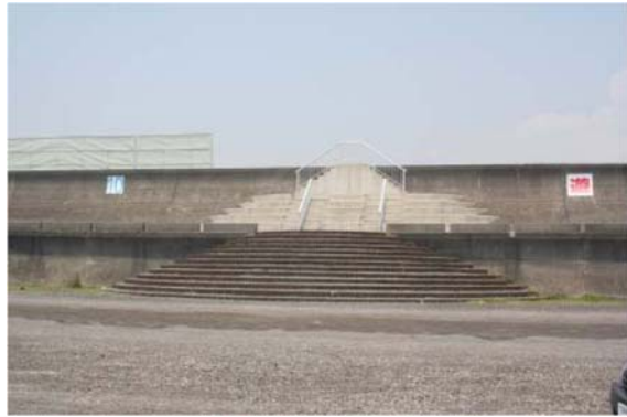
写真-121 形状に連続性が見られない背後のプールから堤外地へのアクセス階段
