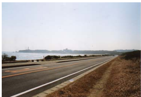
写真-134 転落防止柵を用いず、低木植栽に転落防止の役割を担わせている海岸
