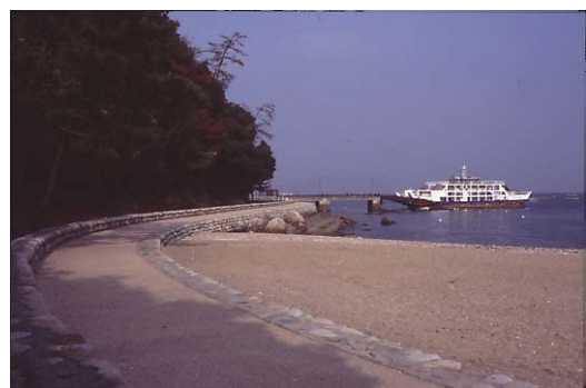
写真-55 岬地形に滑らかにすり付くように配慮された海浜
