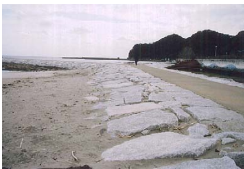
写真-54 突堤と砂浜との滑らかなすりつけに配慮した構造物
