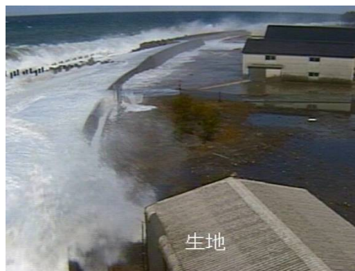
高波の被害（富山県：平成 20 年 2 月）
