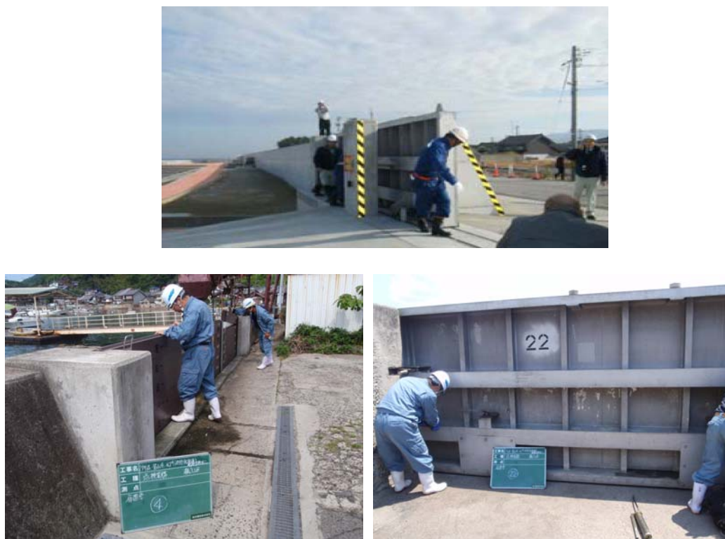
図 6.3 閉鎖施設（水門、陸こう）の点検
