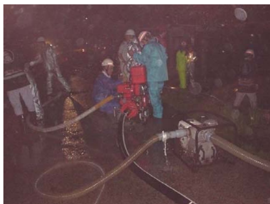
事例③：排水ポンプでの吐出作業
