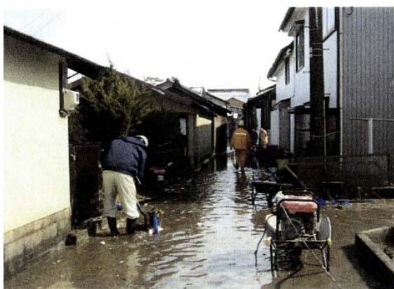
事例③：排水ポンプでの吐出作業
