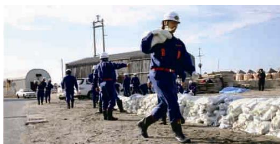
土のうの準備・積み出し
