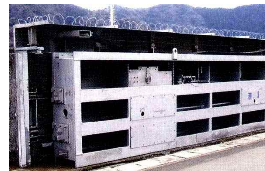
高知県須崎港の事例
