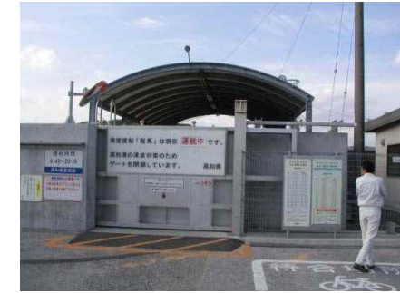
県営渡船の乗降施設 船舶の発着時以外は閉 鎖している事例 (種崎地区)
