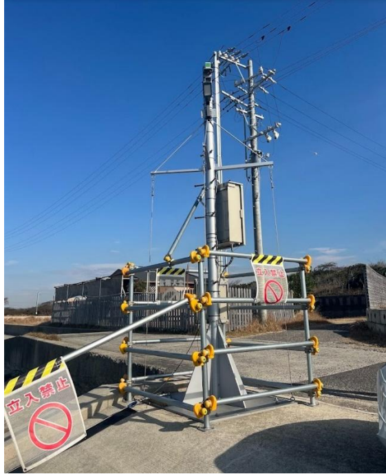
写真-5.2 観測柱に設置する方法
