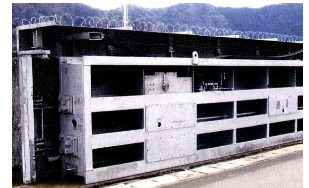
高知県須崎港の事例
