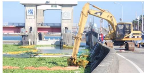
スケルトンバケットを装着したバックホウによる水揚げ
