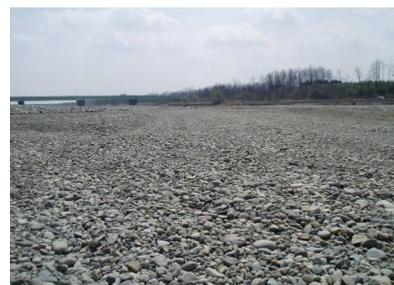
河原の地盤が高い場所を削り、礫を表面に敷きならす
