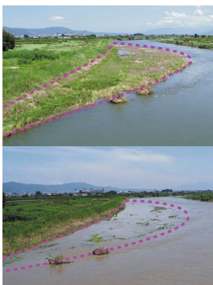
地盤の切り下げを行った例(千曲川) 6)
