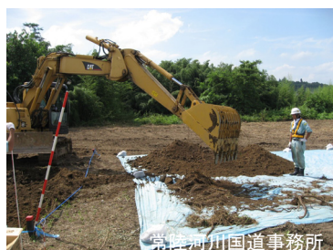
スケルトンバケットによる除根
