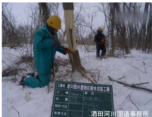
巻き枯らし施工の実施状況(左)と、その後枯れた地上部(中)、おおよび出現した根萌芽(右)
