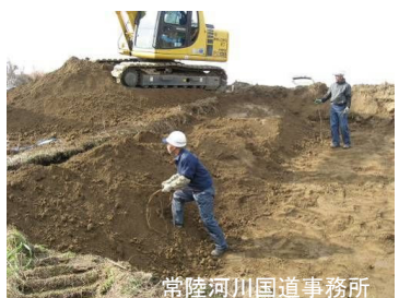
人手による細根除去(那珂川)
