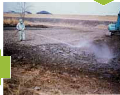
放水により細粒土砂を除去
