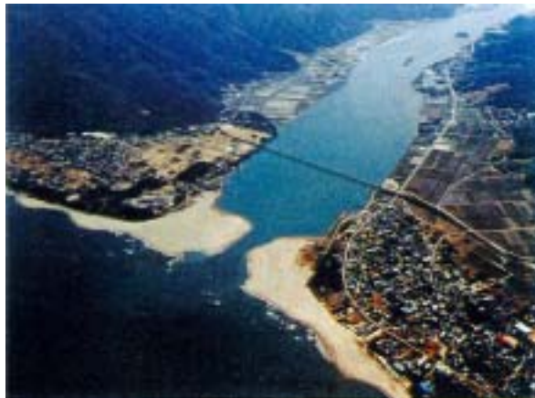
写真1 由良川河口部の空中写真（平水時：平成4年4月）
