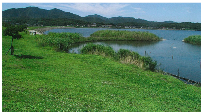
写真 5.1.1 植生帯・ウェットランドの整備状況 3)
