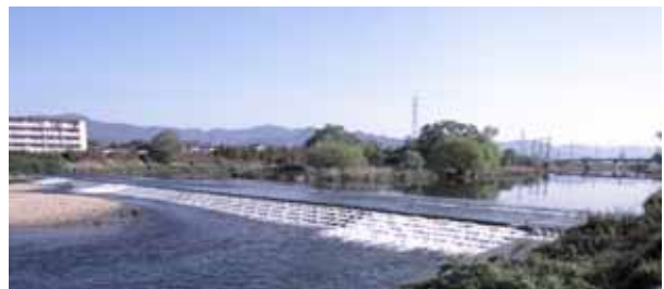
（山口県・榎野川・岩富落差工）
