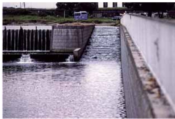
遡上魚が魚道下流端を見つけやすくするために、副ダムを設け、魚道の下流端を上流側に引き込んだ魚道の例
