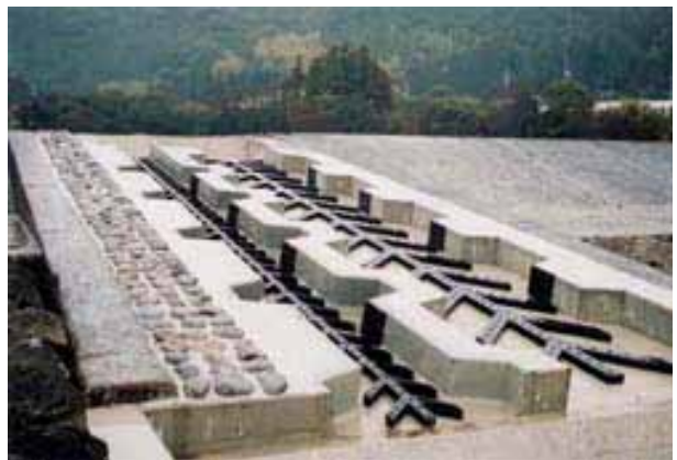
船通し型魚道の底部角材をスチール製とした魚道
