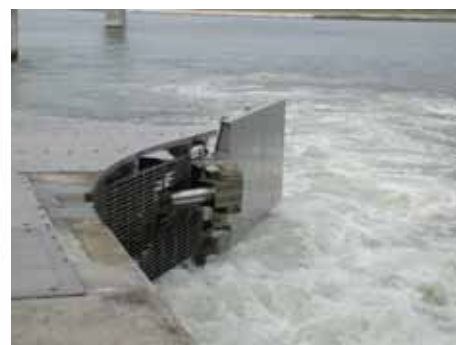
呼び水水路下流端のスイングゲート
