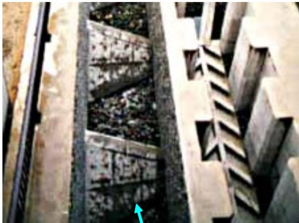
傾斜隔壁式階段魚道
