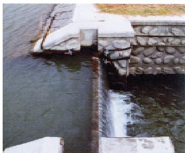
魚道上流端の角落しによる魚道流量の調節
