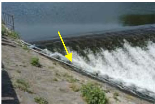
魚道のない固定堰にアユ等の遡上期に簡易な魚道(梯子型)を設置された。アユの遡上が確認されている。
