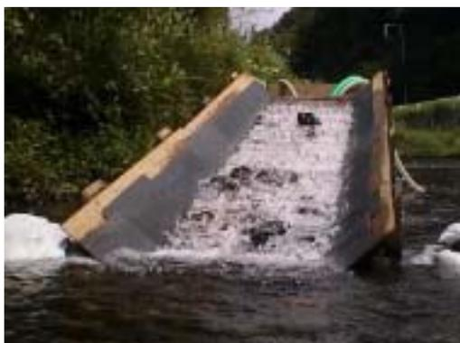
試作された簡易魚道。H鋼及び鋼板の組み合わせに自然石を配置している。魚道勾配は約1/7であるが、甲殻類がよく遡上する。
