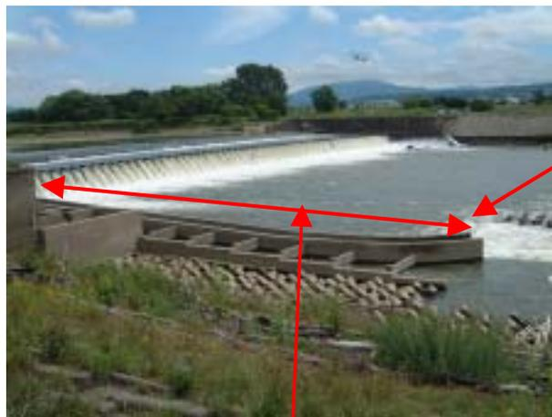
護床工の敷高を上げて堰下への魚の迷入を防いでいる。
