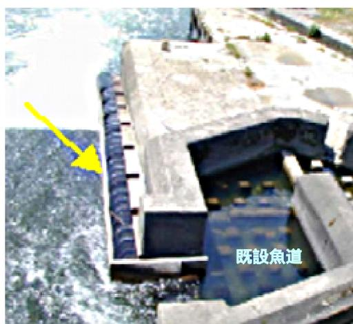
水叩き部の落差が大きく、遡上魚が既設魚道の下流端に達することができないため、水叩き下流側から魚道下流端にかけて一時的に仮設型のデニール式魚道(後付けが可能で、設置も容易なもの)を設置した。
