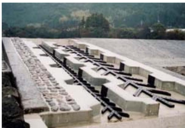
船通し型魚道の底部角材をスチール製とした魚道
