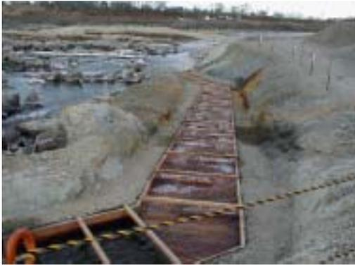
落差が大きく魚が遡上できない横断施設に、試験的に簡易な木製魚道が設置されている。
