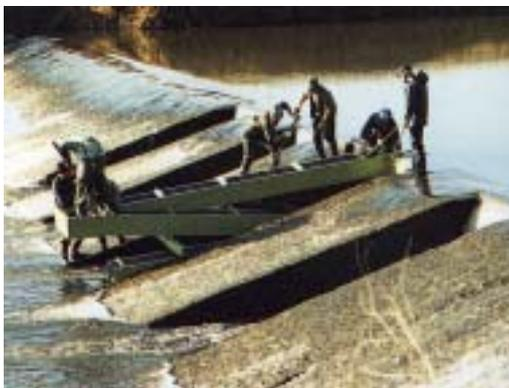
仮設型のデニール式魚道。取り付け、取り外しが容易であり、アユの遡上期に設置され、台風シーズンの前に撤去される。
