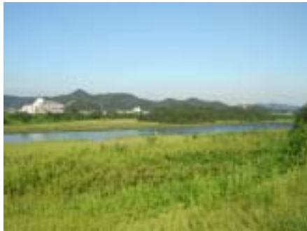
建物が背景に溶け込んでいる大河川の対岸景 *
