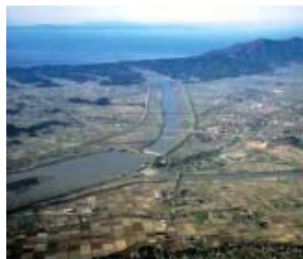
越後平野の開発に貢献した信濃川・大河津分水路 出典：信濃川河川事務所HP
