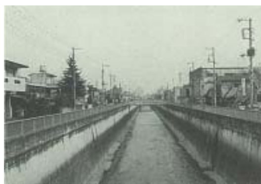
護岸高が大きく河川空間のバランス感に影響を与えている
