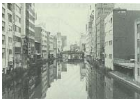
水面に映る建物が幅を狭く見せている
