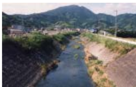
地方の河川も、圃場整備などにより直線化、護岸化が進んだ。*
