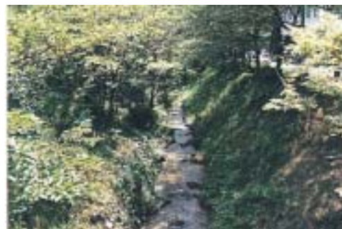
見直し工事をして、自然なステップ&プールを形成
