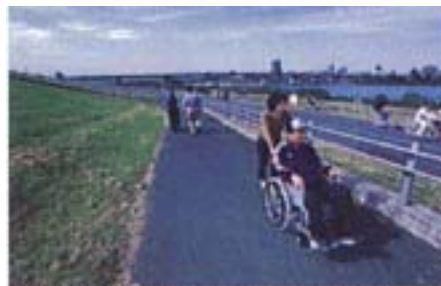
車いすでも利用しやすい勾配が軽いスロープ
