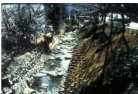
施工直後は石の配置が不自然
