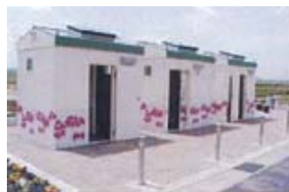
段差のないトイレ（洪水時には撤去可能な構造）
