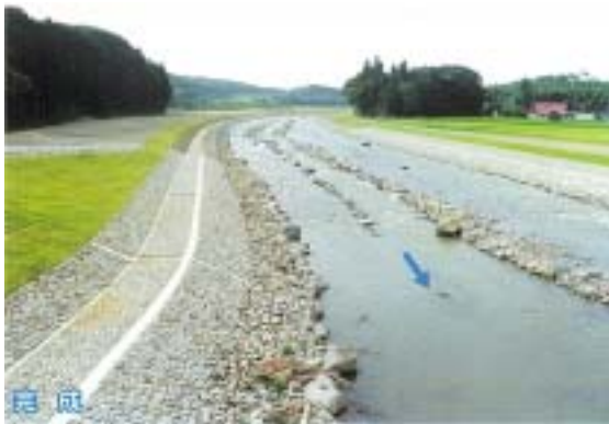
災害復旧による改修直後の状況 提供：栃木県
