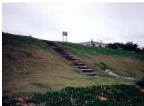
排水樋管の横に取り付けた階段は、景観と、足の感触が良い鉄道の枕木を使用する。
