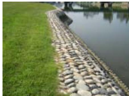
護岸材料として花崗岩切石、玉石の使い方
