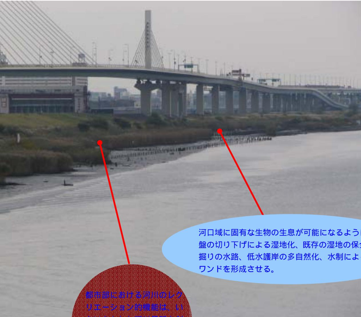
河口域に固有な生物の生息が可能になるように、地盤の切り下げによる湿地化、既存の湿地の保全、素掘りの水路、低水護岸の多自然化、水制による州、ワンドを形成させる。
