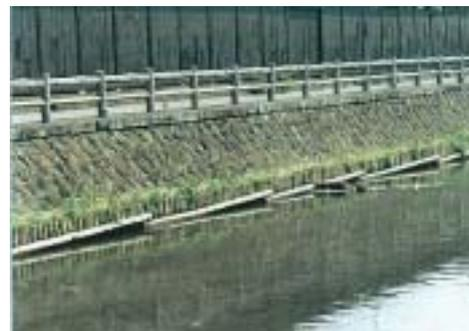
自然石の護岸はコンクリートに比べれば、明度が低く微妙な変化も与えてとけ込みやすい
