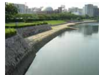
人間の営為が反映された景観 【要素】放水路、水制、ダム、堰、渡船等
