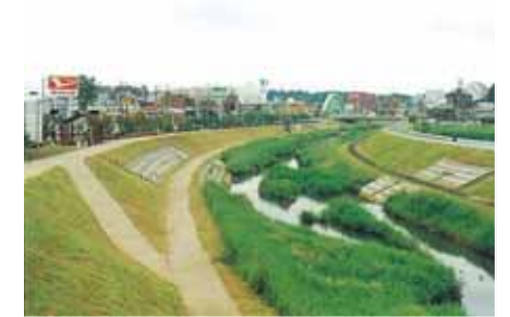
鳥類の営巣に配慮した草刈りの工夫（根木名川） 5)
