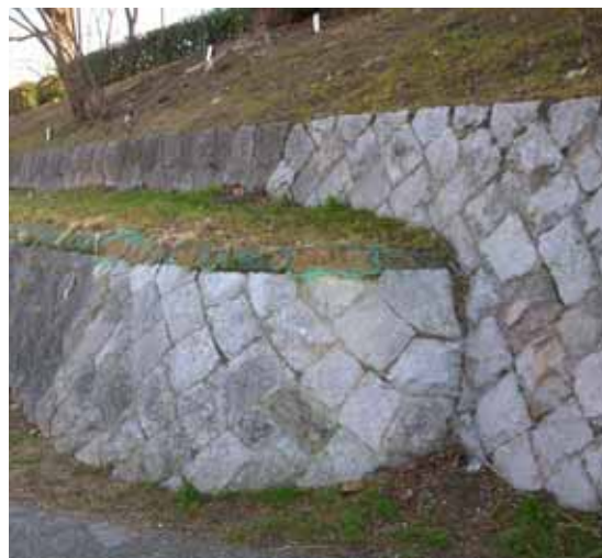
京都府・鴨川 平成10年頃に整備 取り付け部のおさまりがきれいに処理されている
