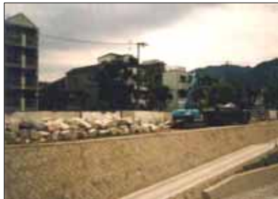
わずかな公有地をヤードとしている例 (兵庫県 神戸県民局)
