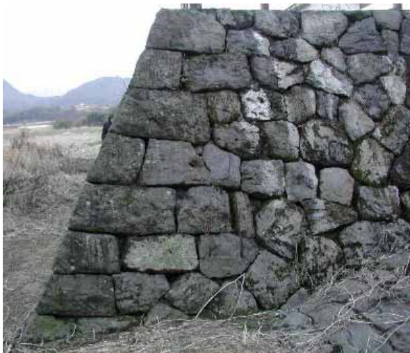
熊本県・緑川 平成17年頃に整備 端部は算木積みで丁寧な処理されている
