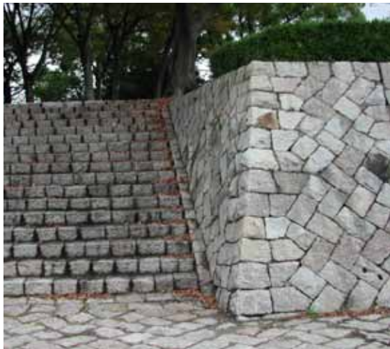
広島県・太田川 昭和 58 年頃に整備 取り付け部・端部ともにおさまりが良い
