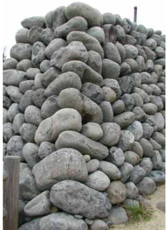
静岡県・横須賀城 平成 10 年頃に整備 河川構造物ではないが、玉石の端部処理でも美 しく仕上げることが可能である。
