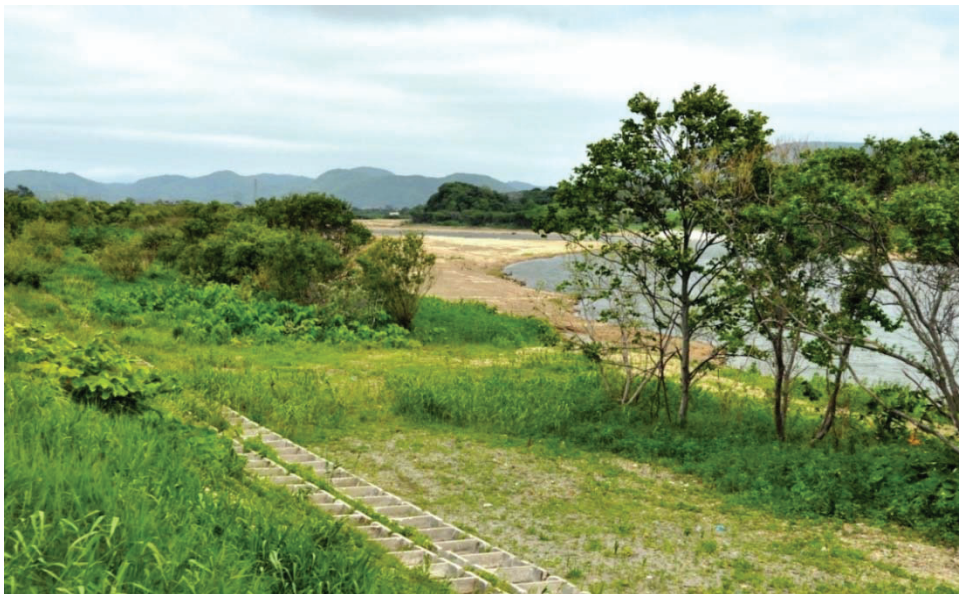
図- 6 高水敷の切り下げ、河畔樹木の存置（厚沢部川）
