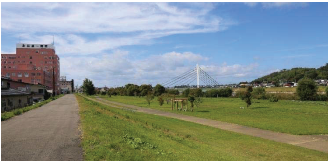
写真-12 改修前後の様子（上：改修前（秋田河川国道事務所提供）、下：改修後）
