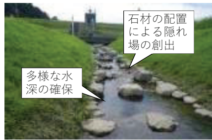
図一11 堤外水路の改良
