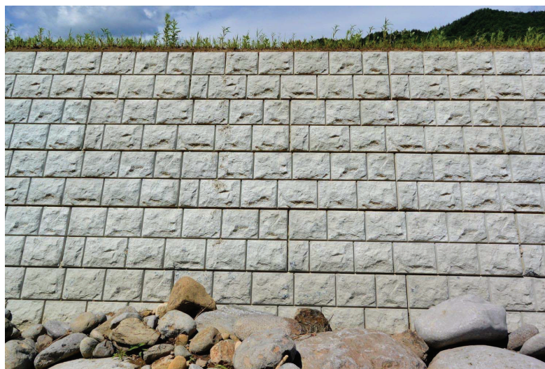
図-27 ブロック内に模様目地を付けた大型ブロック
