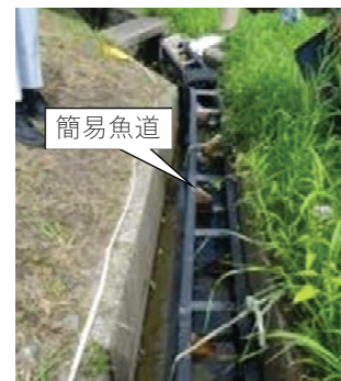
図一12 簡易魚道の設置
