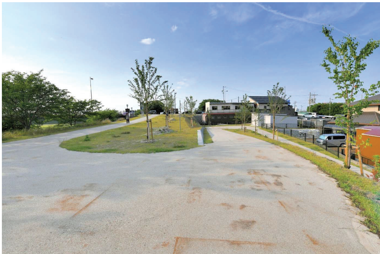
写真-7 度会橋上流水防広場付近
