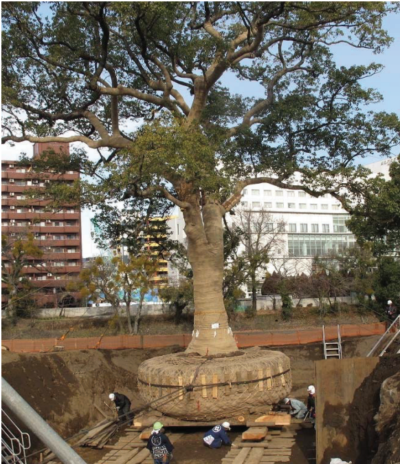
写真-11 大クスノキの移植の様子。小学校の生徒や市民も参加して滑車を動かす（写真右） (熊本大学 星野裕司氏提供)
