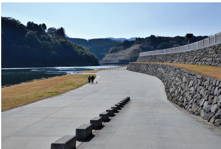
図-17 護岸を一枚法にせず、途中に小段を入れて水平方向に2段に分節している（川内川）
