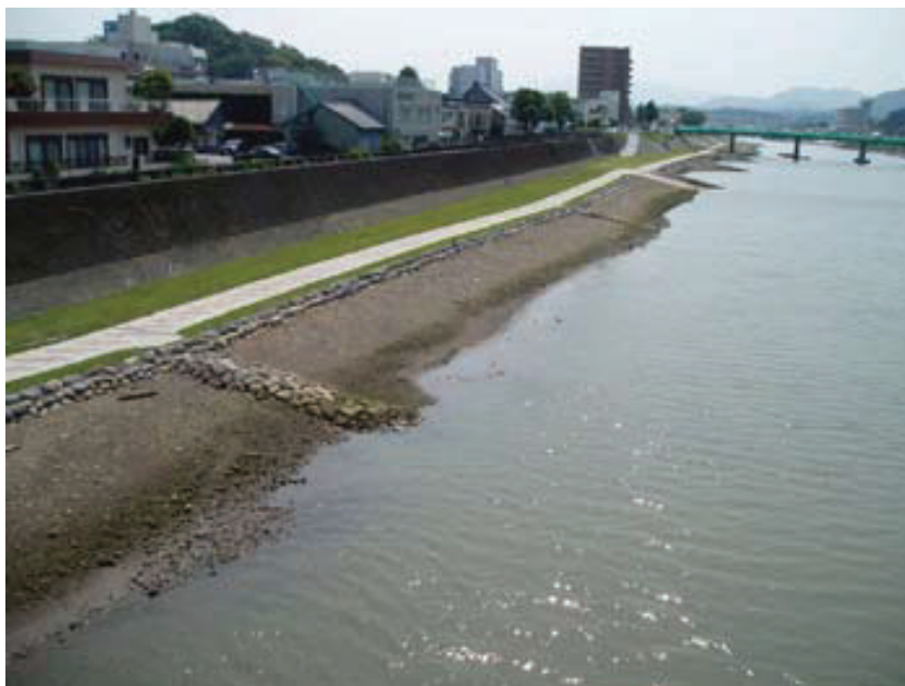
図- 4 潮間帯として整備した緩傾斜河岸の状況（五ヶ瀬川）
