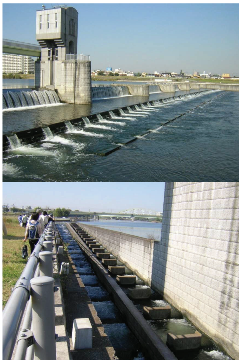
図- 9 改築後の二ヶ領宿河原堰 上：堰全景 下：魚道 (多摩川)
