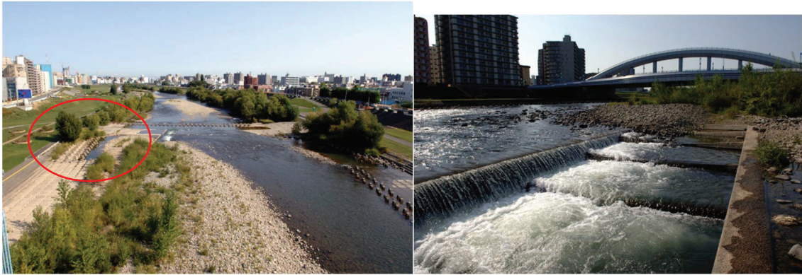
改修前 2006.9 (赤丸は魚道設置位置)
