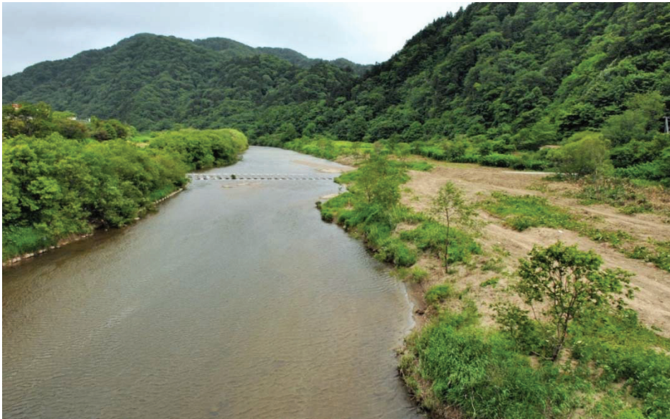
図- 5 水際樹木の存置、背後の樹木伐開と掘削（厚沢部川）
