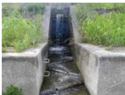
樋管の吐口部の魚道設置
