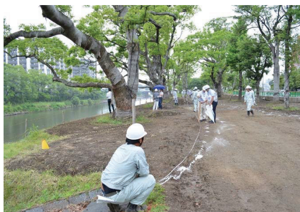
写真-12 木立の中を通る遊歩道。写真下は線形を決定している様子 9)。
