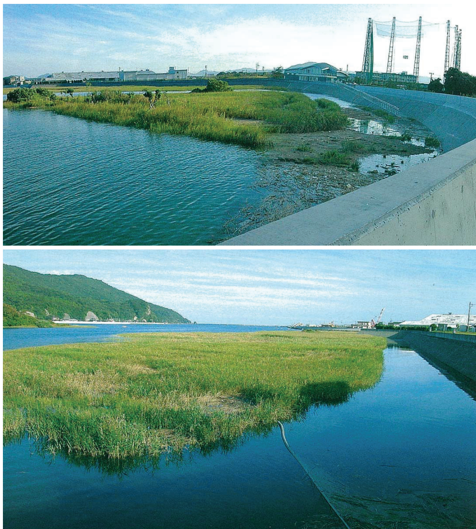
図- 12 特殊堤を用いて河川環境へのダメージを最小限にした例（北川）
