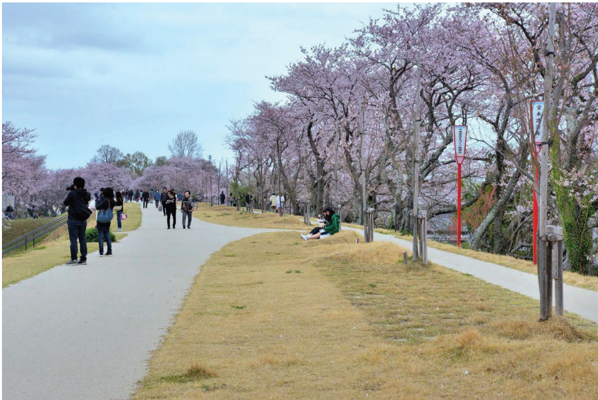
写真-4 本堤防（左 7m）と側帯（右 5m）。本堤防の河川管理用通路舗装は従前の 3m 幅とし、緑地（芝生）面積を多くとり柔らかい景観となるようにした。本堤の天端下全面に遮水シートを設置して、本堤への雨水浸透を防いでいる。支柱がついた桜が新しく植えた桜。桜の根元に配置した三日月上の小盛土は、水防活動の際に必要な土のう材料として位置づけているが、普段はベンチとして利用を想定してデザインしたものである（月ノ輪と名付けた）。
