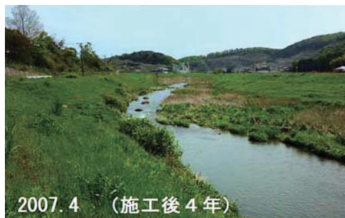
図-9 覆土による自然な河岸の形成（牛津川）
