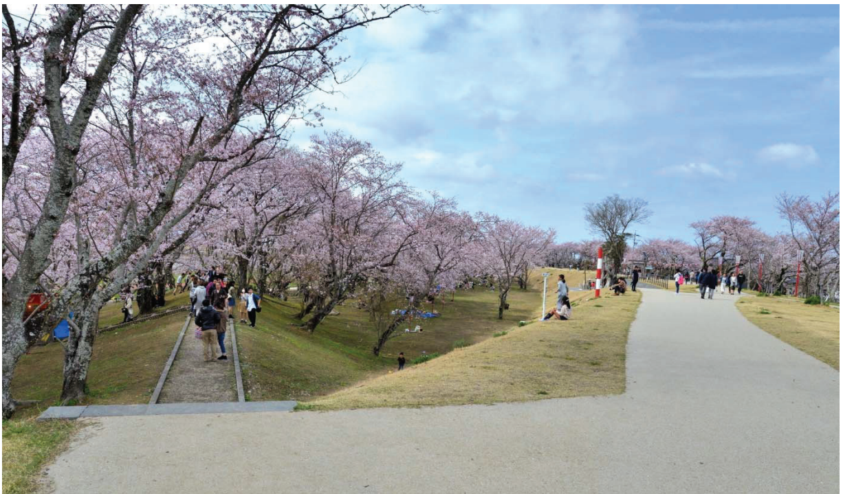
写真-3 整備前（上）と整備後（下）。写真左の堤防が駿河守堤と呼ばれる突出し堤。整備前の桜景観は素晴らしいが本堤防が狭い。整備後は堤防天端幅が5mから12mに広がり、伸びやかな空間に変貌した。腹付盛土による突出し堤長さの減少も最小限となり、景観的にも大きな変化は見られない。
