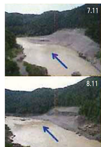
図-6 置土の流下状況 4) （平成 26 年 小計箇所）
