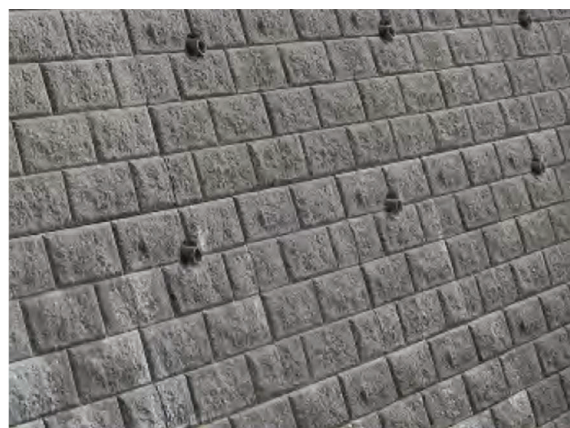
図-22 明度に工夫した護岸（釧路川）
