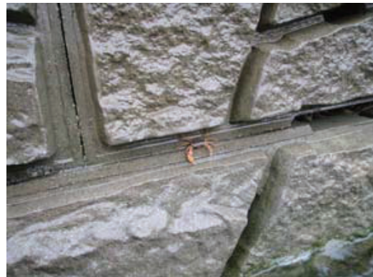
河岸法面を移動中のサワガニ。河岸は空積ブロック護岸（擬木模様）※
