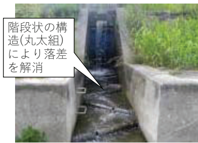
図一10 樋管の吐口部の改良
