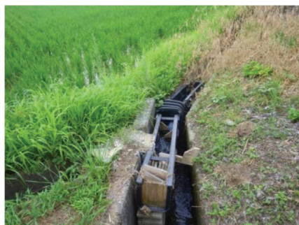
簡易魚道の設置
