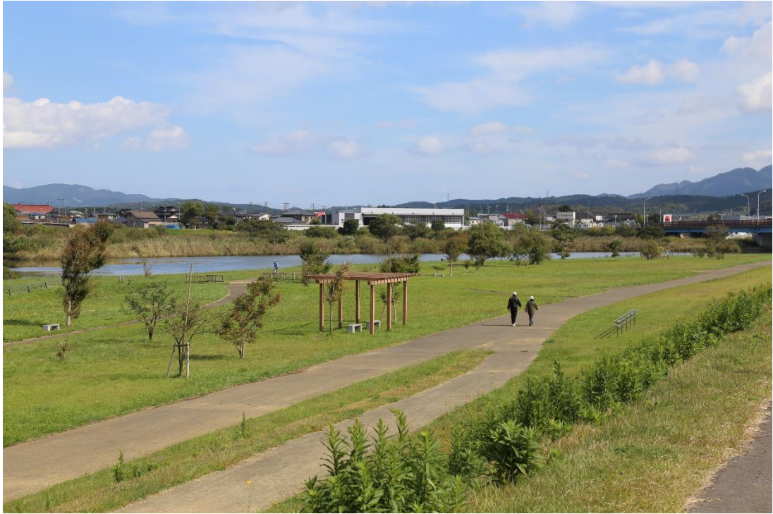
写真-10 堤防から広場、川までが一体的に連続 (2016.10)
