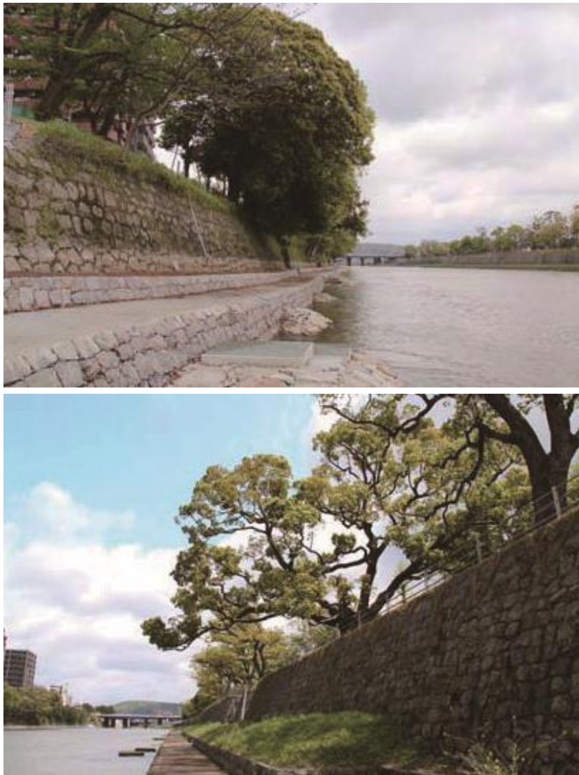
図- 10 右岸側で保全した石積み護岸（上）と、 左岸側で整備した石積み護岸（下）（白川）
