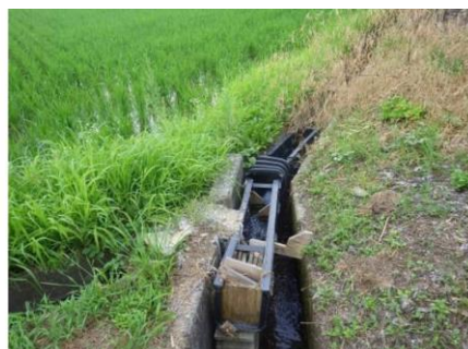
簡易魚道の設置
