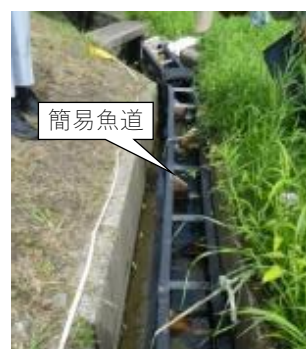
図一12 簡易魚道の設置
