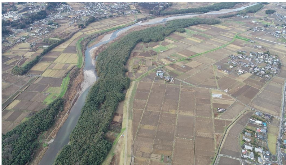
写真 4 河川に沿って存在する水害防備林
