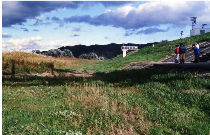
写真-1 整備前の様子（(株)プランニングネットワーク 伊藤登氏提供）
