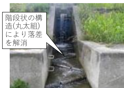
図一10 樋管の吐口部の改良
