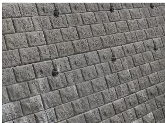
図-22 明度に工夫した護岸（釧路川）
