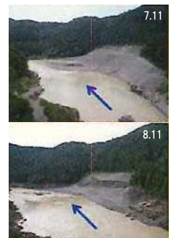
図-6 置土の流下状況 4) （平成 26 年 小計箇所）
