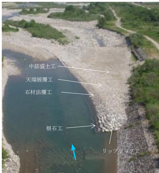
図-8 巨石付き盛土砂州を用いた河岸防護工の構造
