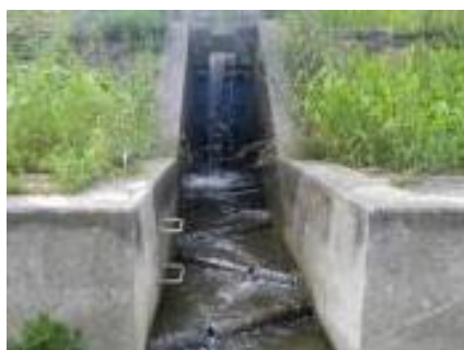
樋管の吐口部の魚道設置
