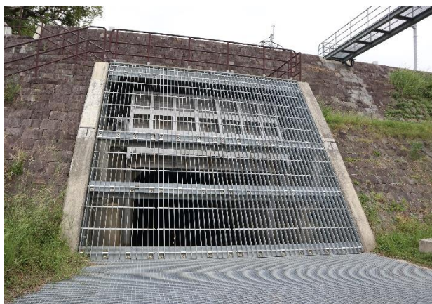
図-31 排水樋管の取り付け護岸に、石積み護岸を採用し、景観に配慮した事例 (筑後川)
