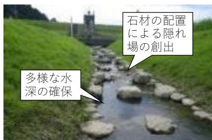
図一11 堤外水路の改良
