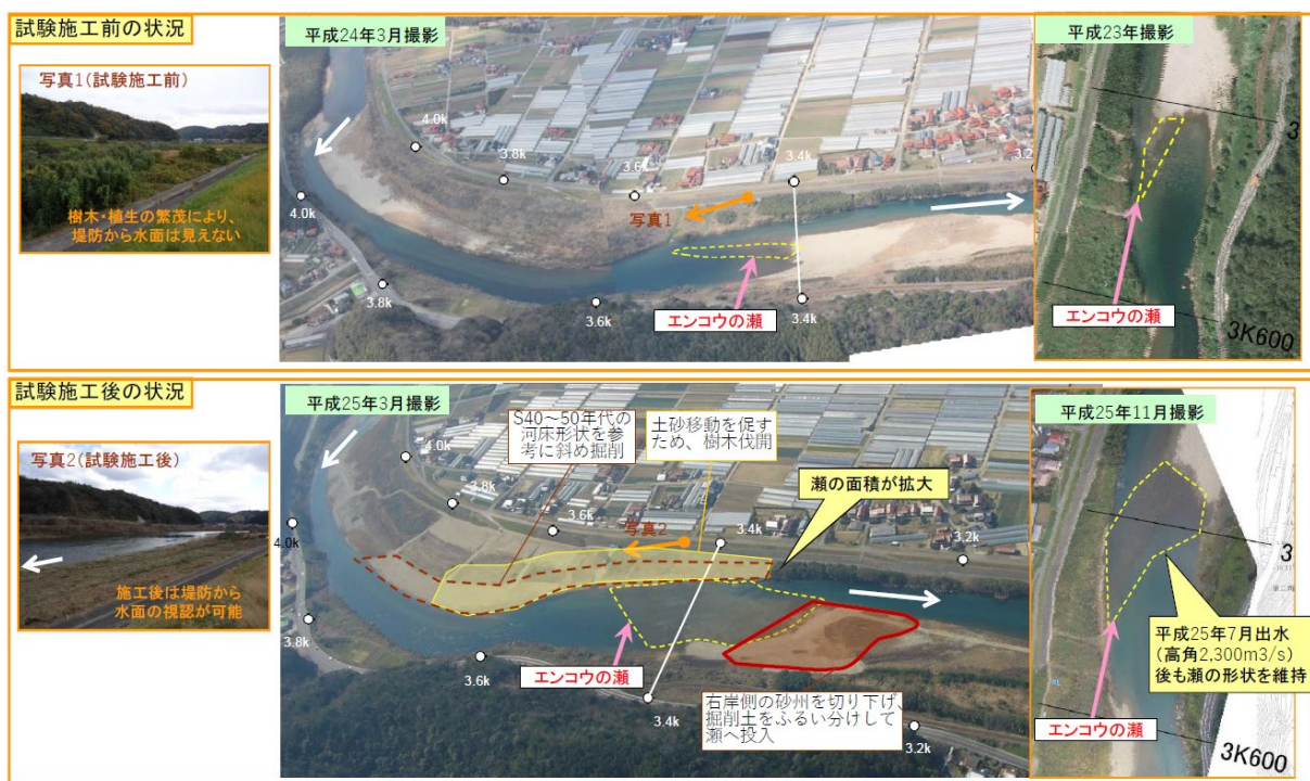
図 12 高津川 エンコの瀬における試験施工 28)
