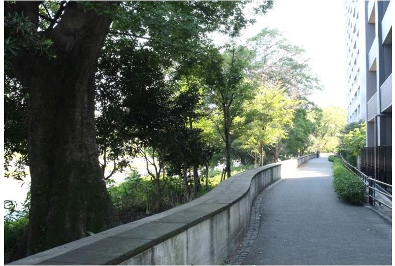
写真-10 堤防法線をカーブさせて木を保存（右岸） （熊本大学 星野裕司氏提供）
