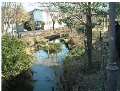
図ー7 コンクリート水路撤去の事例 4)
