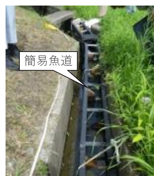
図一12 簡易魚道の設置
