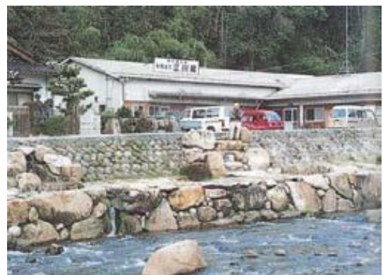
図-26 素材単位の見えが大きすぎる例
