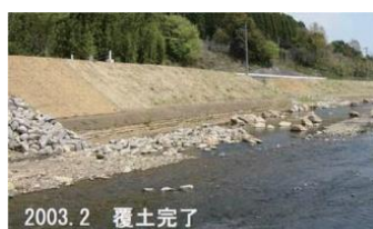
図-9 覆土による自然な河岸の形成（牛津川）
