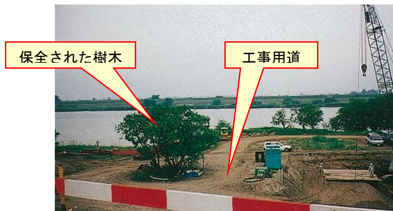
図-33 周辺の植生に配慮して工事用道路等を設置した例（長良川） 17)
