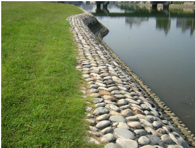
図-19 のり肩の工夫（太田川）
