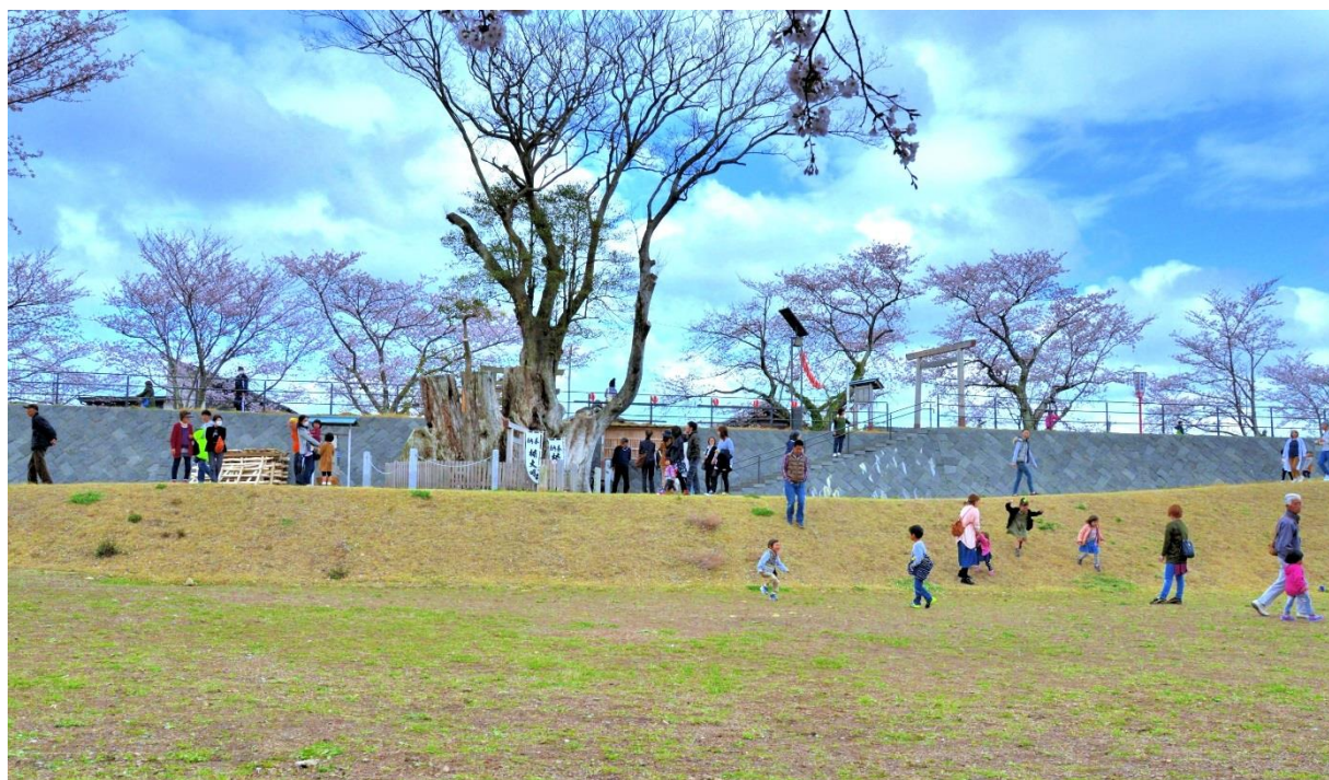
写真-6 境楠。護岸を立てて現存する境楠を保全し、合わせてスロープと階段を設けて境楠や高水敷へのアクセスがしやすいように整備した。
