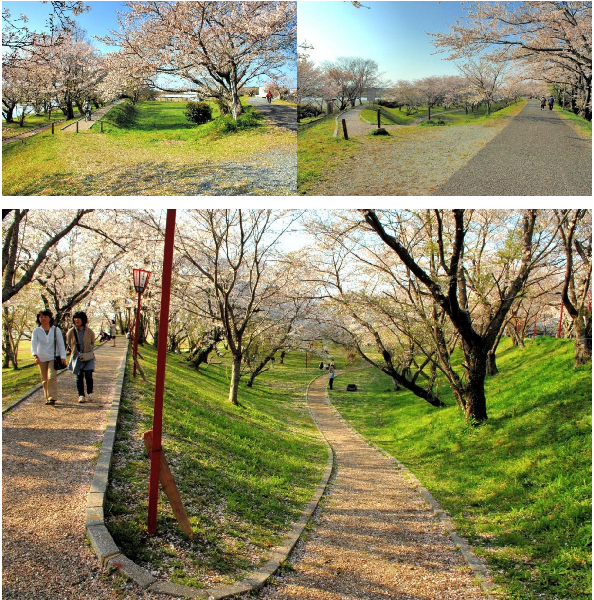
写真-1 現存する江戸時代の突出し堤（堤防拡幅工事前 2012）。上左：棒堤（1685）、上右：周防守堤（1702）、下：駿河守堤（1685）。水制工は本堤から下流方向に突き出すような形で配置されている。
