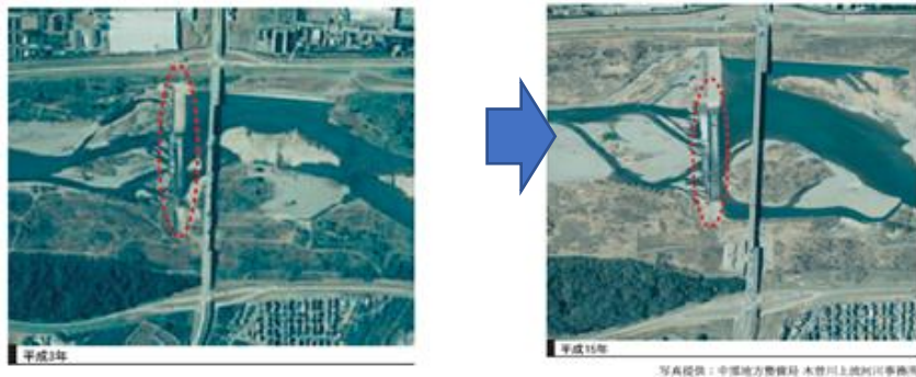
図-3 滯筋の変化の例 滯筋の変化により、床固工（円内）上下流の砂州形状が変動している。
