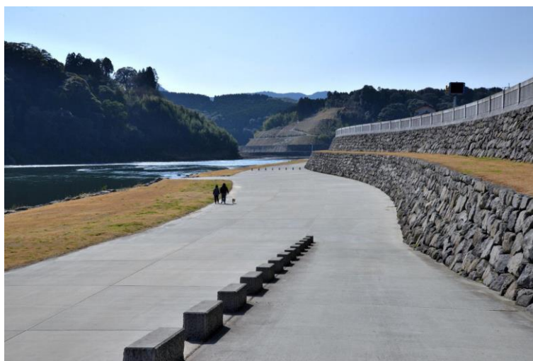
図-17 護岸を一枚法にせず、途中に小段を入れて水平方向に２段に分節している（川内川）
