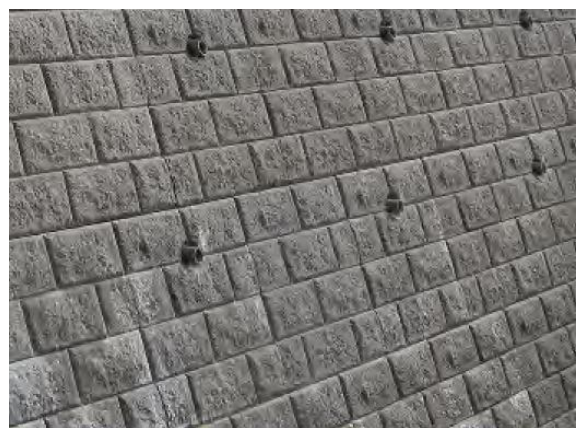
図-22 明度に工夫した護岸（釧路川）
