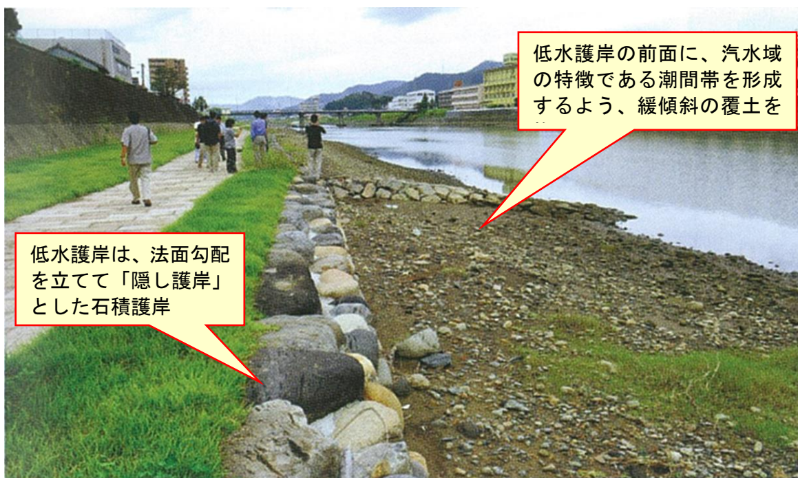
図-10 護岸前面に汽水域の特徴である潮間帯を形成（五ヶ瀬川）
