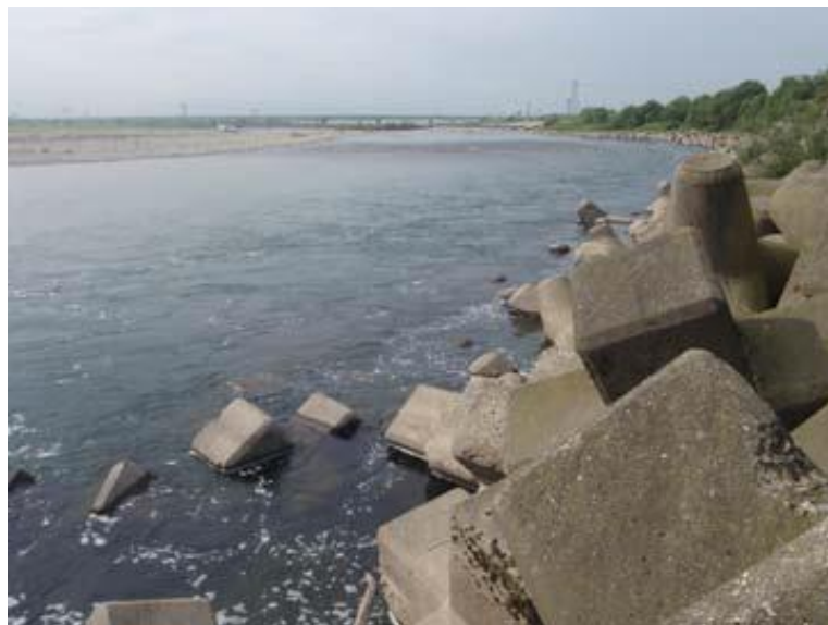
図-13 水衝部の淵のブロック（神通川）
