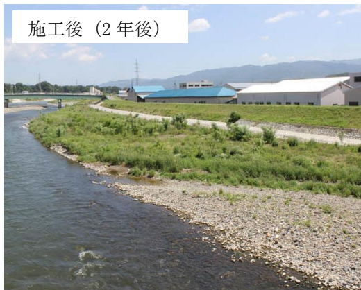
図-5 仮締切の盛土を用いた護岸前面への寄州の形成（天竜川）
