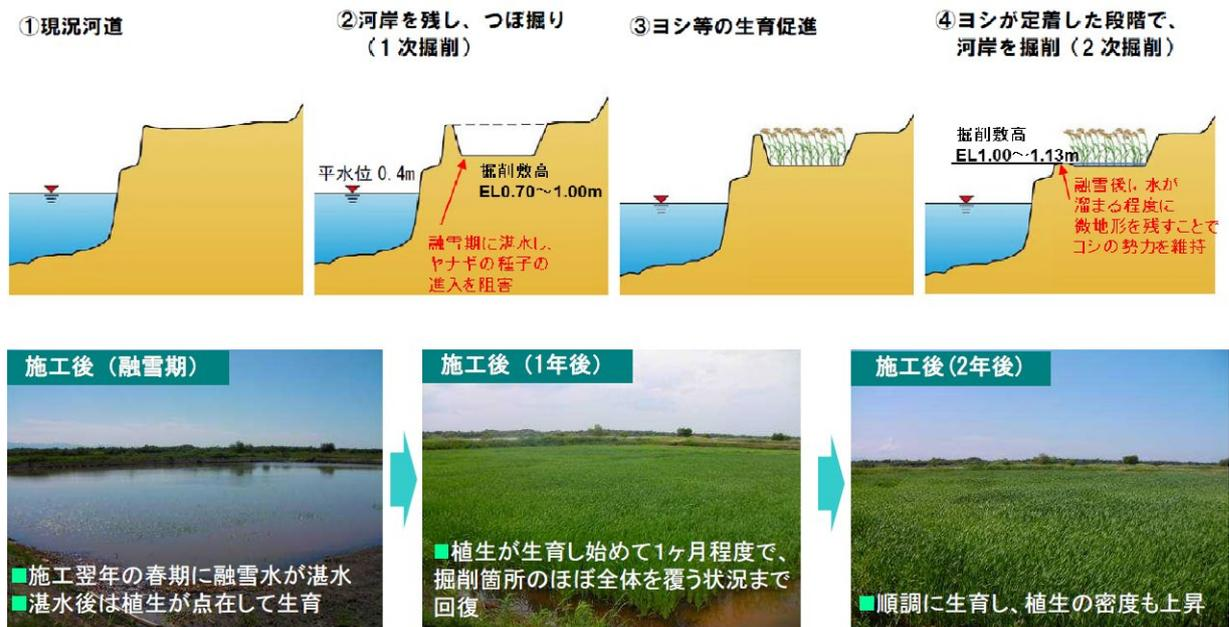
図 16 石狩川における河道掘削の模式図と施工後の経過写真<sup>27)</sup>
