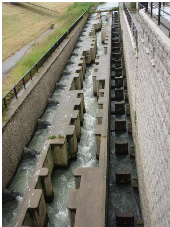
図-4 多様な魚種に対応するために、複数の魚道形式を併設した事例（信濃川 洗堰）魚の遡上経路に配慮し、河岸側から中心に向かい魚道内遡上経路の流速が速くなるよう設計されている
