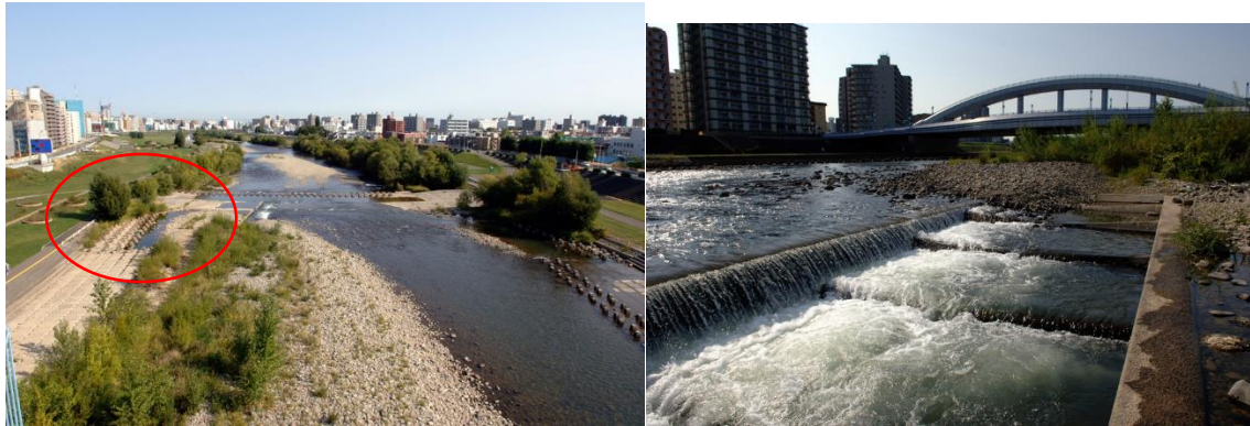
改修前 2006.9 (赤丸は魚道設置位置)
