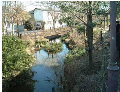
図ー7 コンクリート水路撤去の事例 4)
