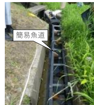
図一12 簡易魚道の設置
