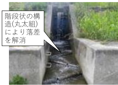
図一10 樋管の吐口部の改良
