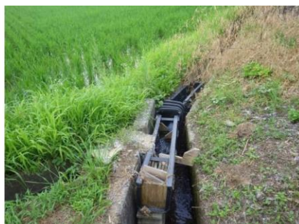
簡易魚道の設置
