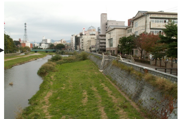
図 護岸前面に盛土、護岸中段の植栽により護岸の露出面積を小さくしている（中津川）
