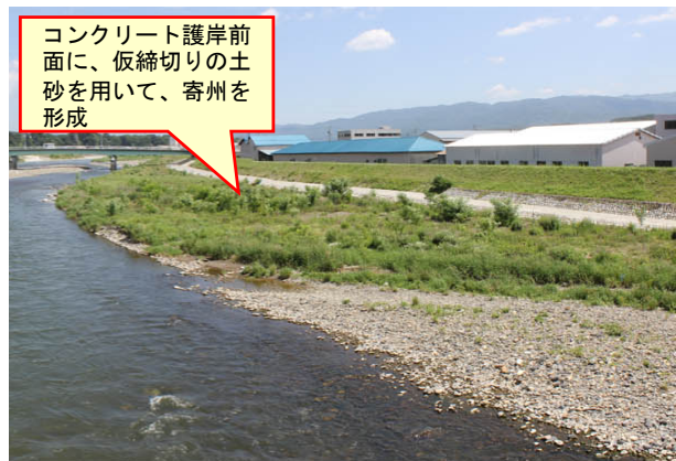
図 護岸前面に寄州を形成した事例（天竜川）
