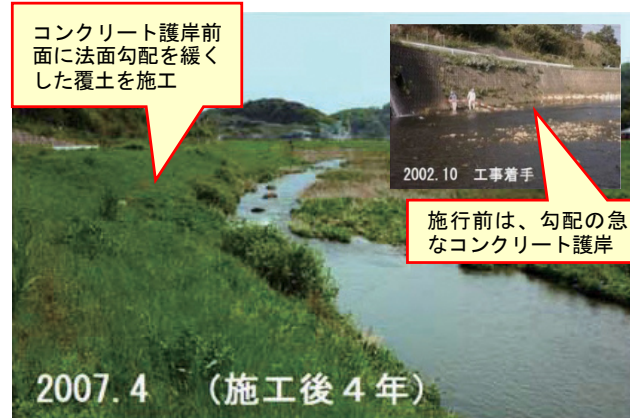
図 覆土による自然な河岸・水際線の形成事例（牛津川）
