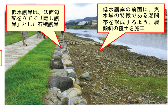
図 緩傾斜の覆土による潮間帯の形成事例（五ヶ瀬川）
