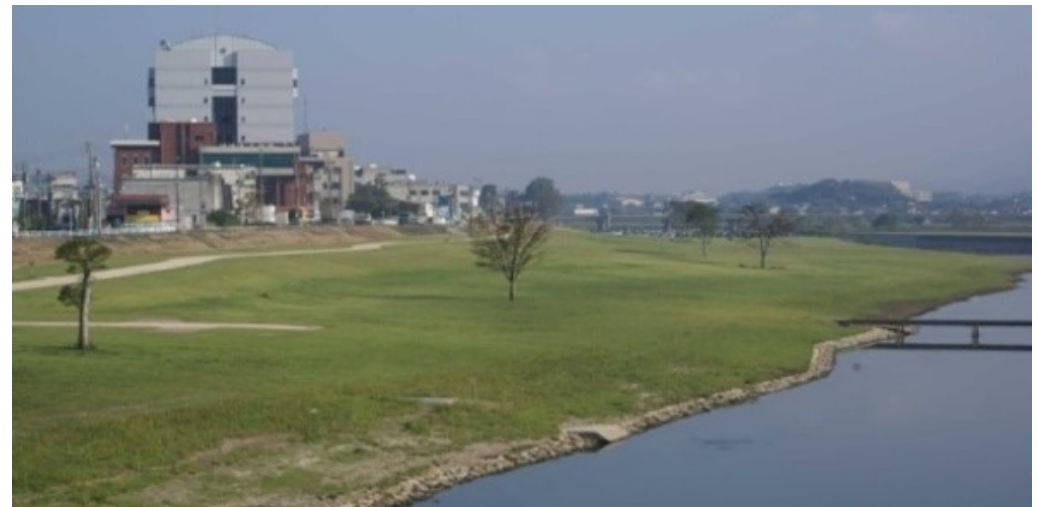
改修後の様子
