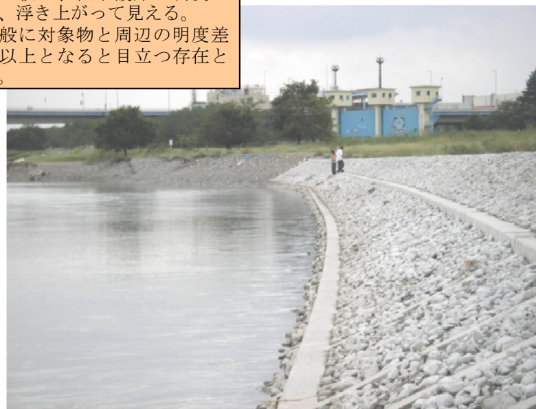
非常に高明度の低水護岸
