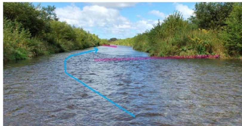
水制を配置して掃流力を上げた事例
