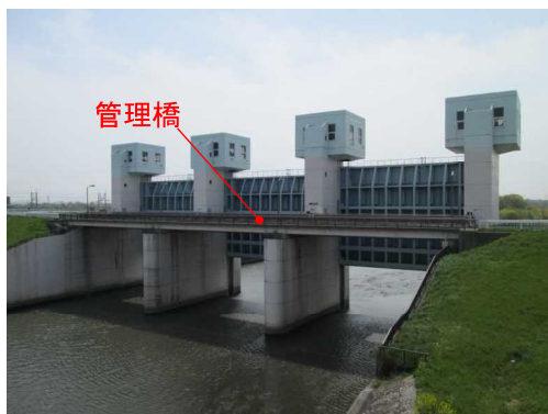
水門の事例(荒川昭和水門)
