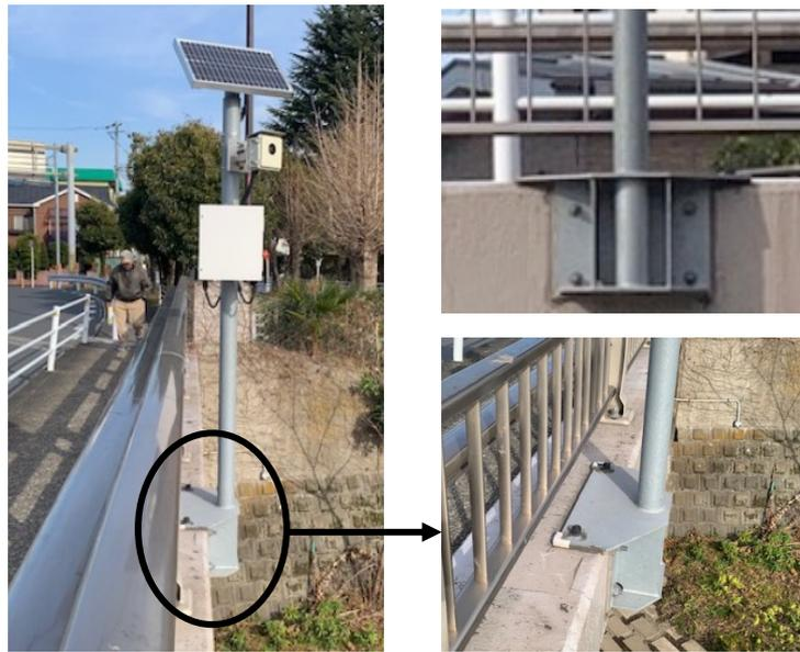
図 5-4 橋梁地覆にベースプレートをボルトで締め付け固定した事例
