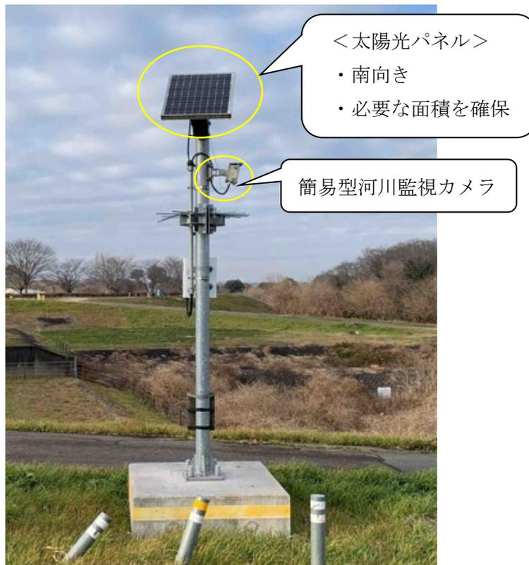
図 5-1 太陽光パネルの設置
