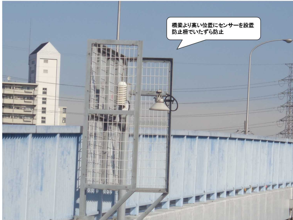
写真 3-13 橋梁より高い位置に設置している例
