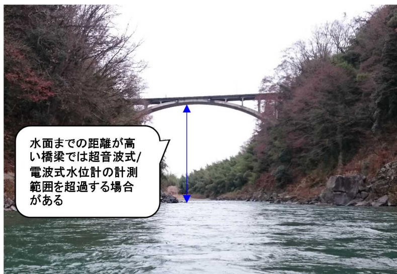
写真 3-12 水面までの高さがあり超音波式/電波式水位計に適さない橋梁
