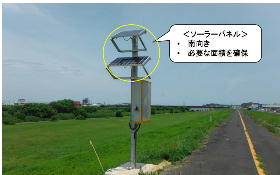
写真 3-2 ソーラーパネルの設置
