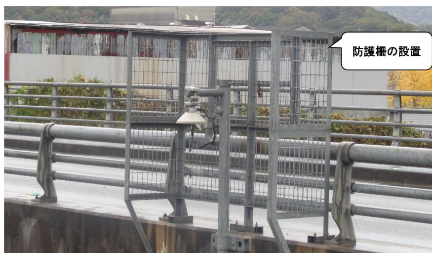
写真 3-6 橋梁設置の場合の防護柵の例
