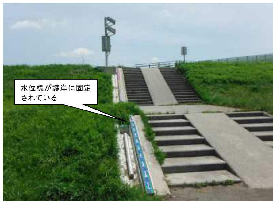
写真 3-15 水位標設置イメージ
