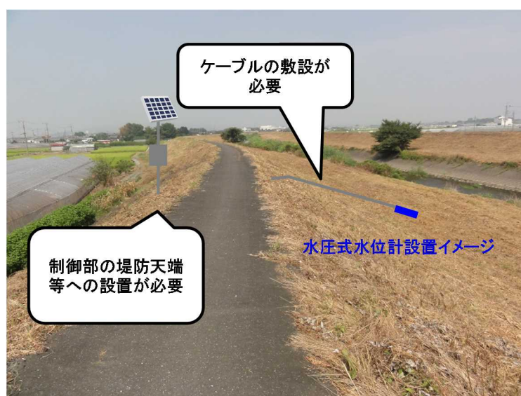
写真 3-14 堤防への水圧式水位計設置イメージ
