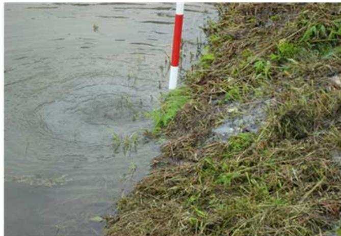
写真 - 2 法尻からの漏水の事例
