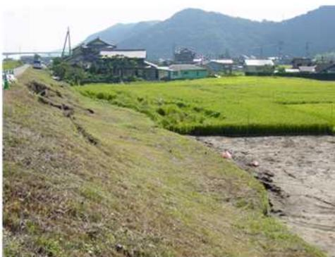
(a) すべりによる堤防の破壊事例
