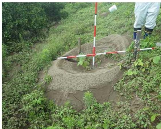
(b) 法尻付近で発見された噴砂を伴う漏水
