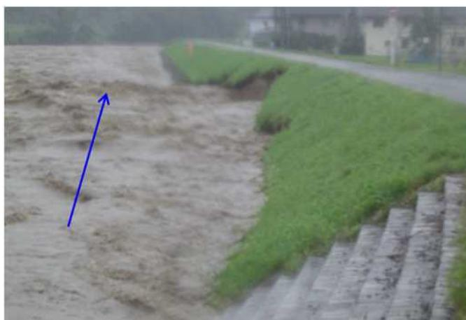
写真 - 7 表法面の侵食が発生した事例
