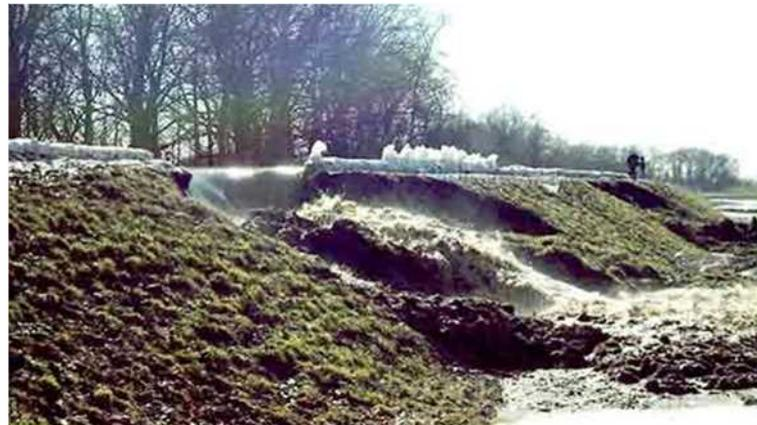
写真 - 10 堤防天端に達するすべりが発生した事例
