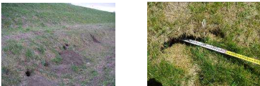
図 - 5 キタキツネ穴の例(左) 及び 深さ 4 m 近く計測された巣穴の実態(右)
