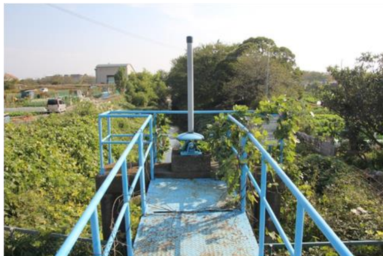
千疋排水樋管
