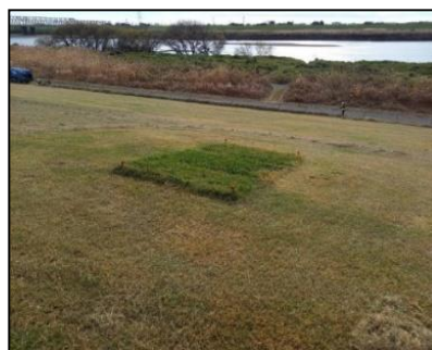
シバ養生箇所
