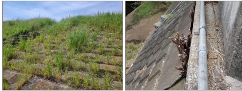
接続ブロック等の構造物周り
