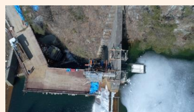
取水施設設置時の施工風景
