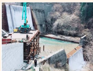
仮設栈橋の設置時の施工風景
