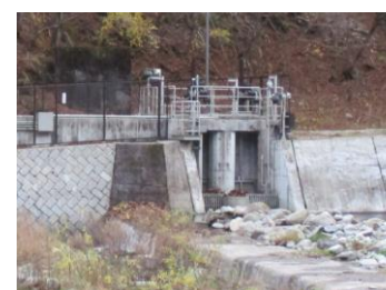
図7.9 取水口のゲート
