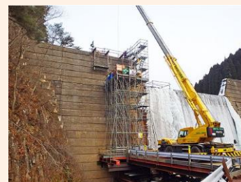
コンクリート削孔工事
