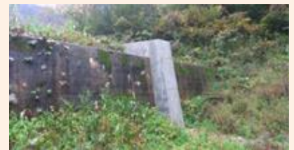
コンクリート巻立ての取水管
