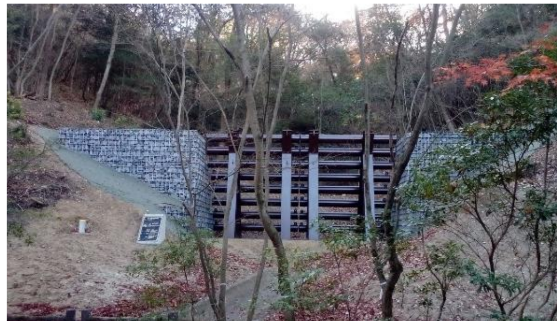
星ヶ台第2砂防堰堤 左支溪 (H=4.0mタイプ)
