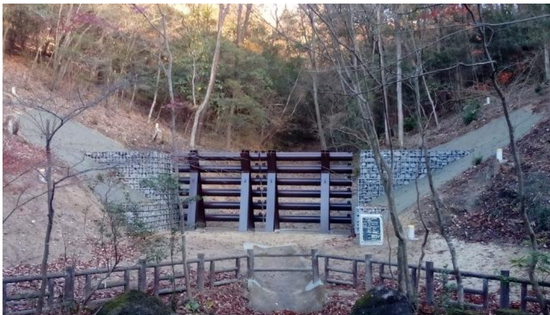
星ヶ台第1砂防堰堤 右支溪 (H=3.0mタイプ)
