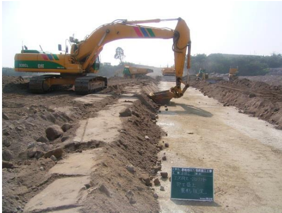
写真-2.12 土砂型枠設置（従来）
