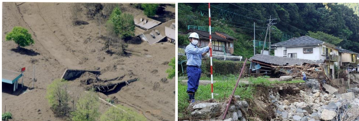
写真-5.1 現地調査状況（左：有珠山 右：令和2年7月豪雨）
