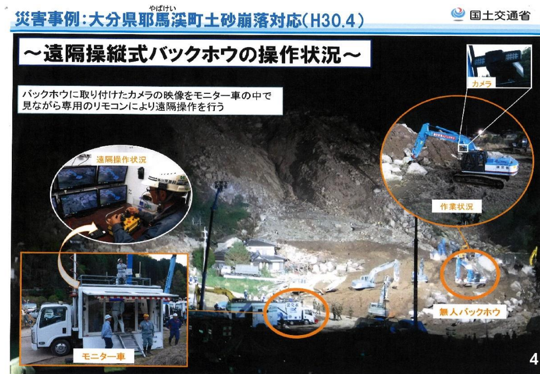
図-1.2 九州地方整備局等による初動対応の事例
