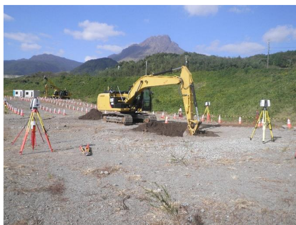
写真-4.4 No. 6 現場実証状況（R1）
