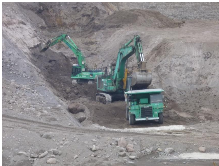
写真-1.1 遠隔施工による掘削積込運搬（雲仙普賢岳）
