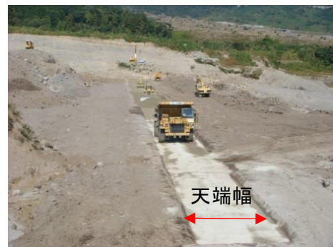
写真-2.9 RCC コンクリート運搬状況
