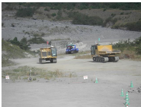
写真-5.5 遠隔操作による運搬状況
