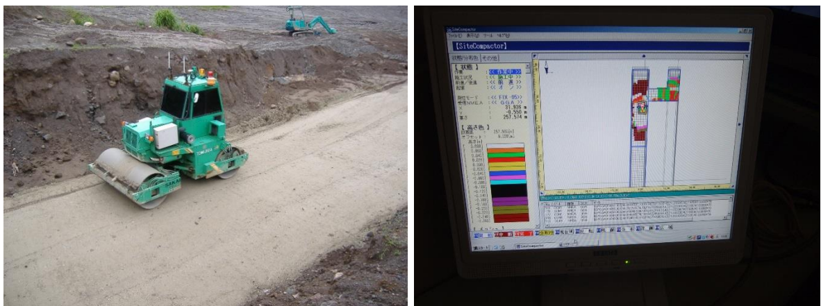
写真-3.20 転圧管理システムを搭載した振動ローラおよび管理画面
