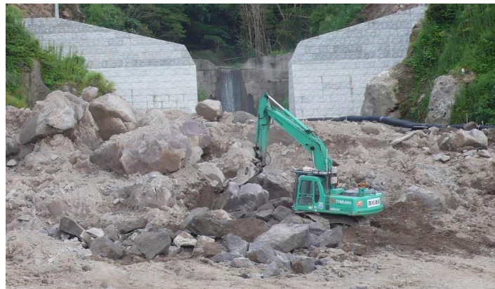
写真-2.4 遠隔操作式バックホウによる転石破碎（南大隅町）
