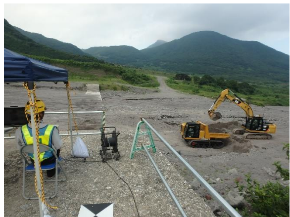
写真-4.1 地元企業による無人化除石試験施工（目視操作）
