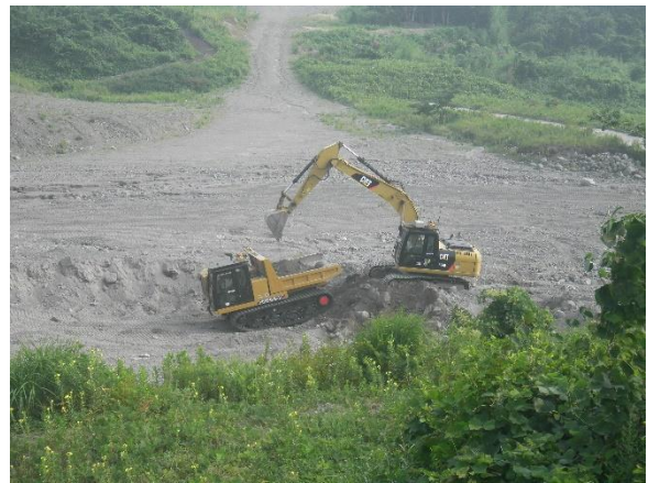
写真-4.2 地元企業による無人化除石試験施工（映像視認）
