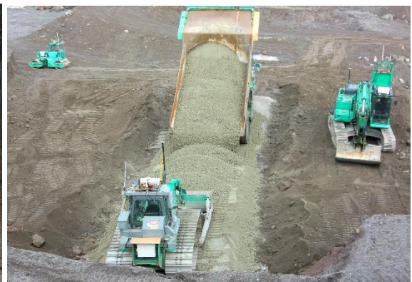
写真-1.7 砂防堰堤工（RCC）（雲仙普賢岳）
