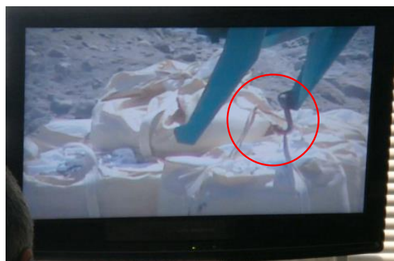
写真-2.8 加工した吊フック
