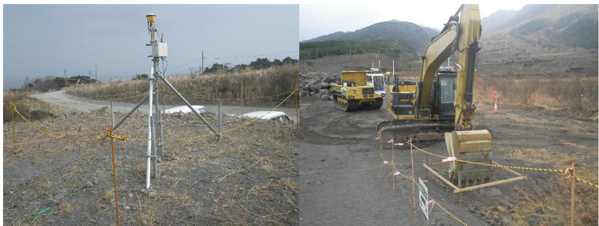
写真-5.7 GNSS 基準局（左）および GNSS 精度確認状況（右）
