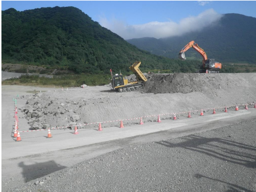
写真-5.2 土砂仮置場での有人遠隔輻輳作業
