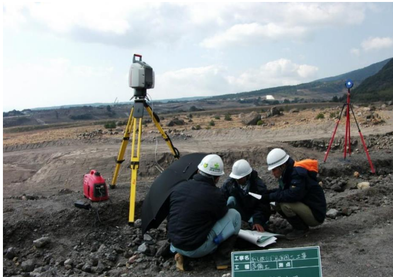
写真-8.1 3D スキャナを使用した完了検査
