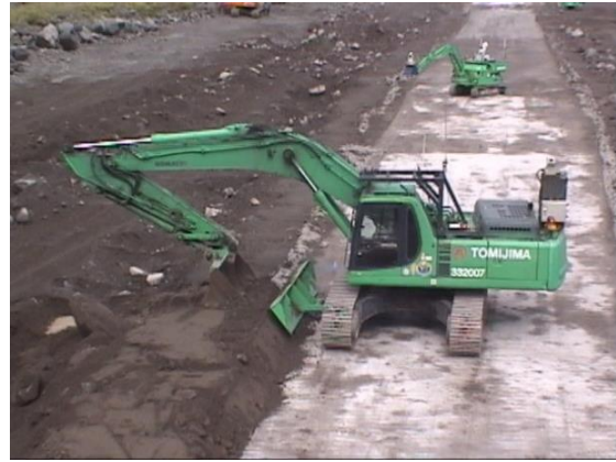
写真-2.13 補助ブレードによる施工
