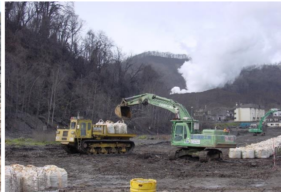
写真-1.5 大型土のう積工（有珠山）
