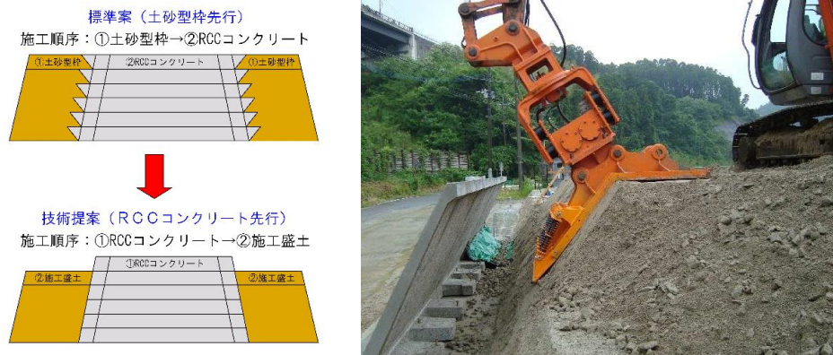
図-2.6 RCC 先行打設工法の概要
