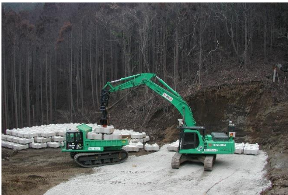
写真-1.6 護床ブロック積工（三宅島）
