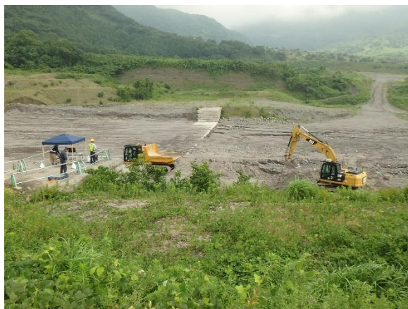
写真-4.1 地元企業による無人化除石試験施工（目視操作）
