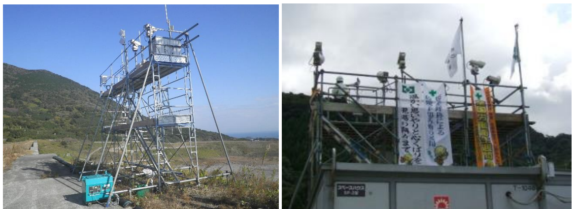
写真-3.17 無線基地局
