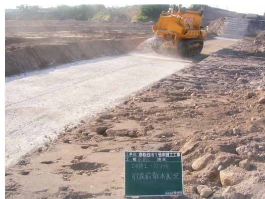
写真-2.11 無人散水状況
