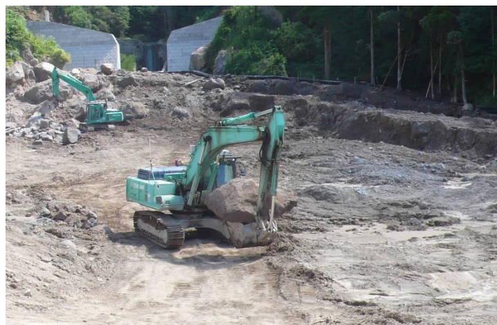
写真-2.5 遠隔操作式バックホウによる転石持ち出し（南大隅町）
