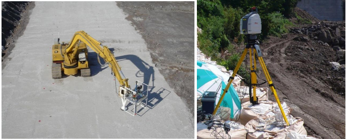
写真-7.2 無人測量車（左），3Dスキャナ（右）による出来形計測
